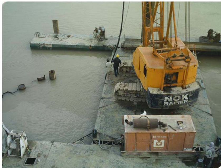
پروژه بارج مدولار رودخانه ای روی رود کارون جهت احداث پل محور نظامیه - میاندشت
