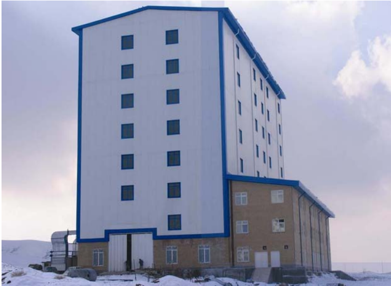
پروژه سالن صنعتی سازمان هوا فضا (ارتفاع سالن ۴۰ متر)
