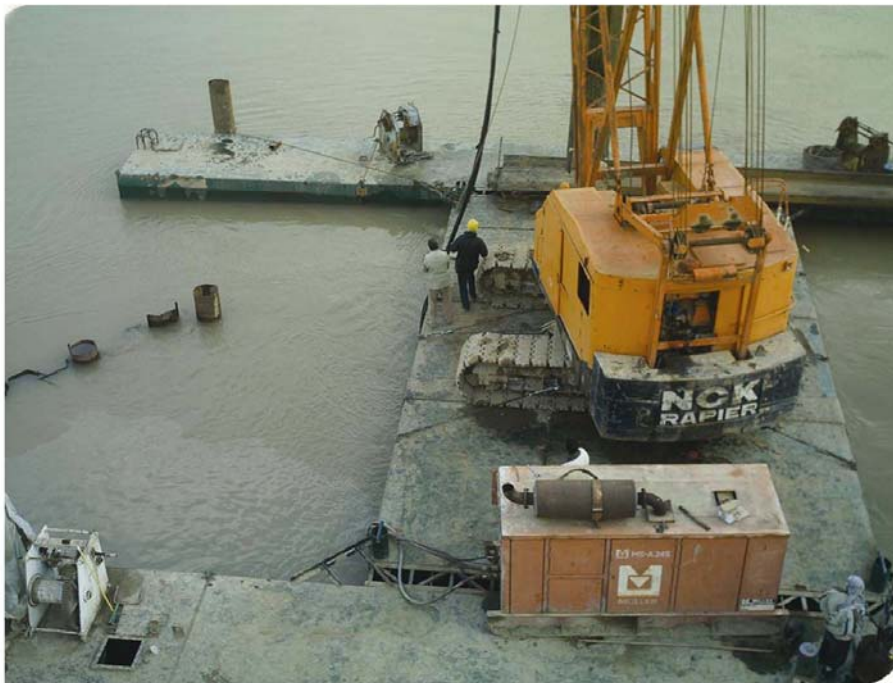
پروژه بارج مدولار رودخانه ای روی رود کارون جهت احداث پل محور نظامیه - میاندشت
