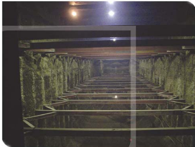
پروژه ساختمان سرپرستی بانک ملت استان خراسان رضوی
