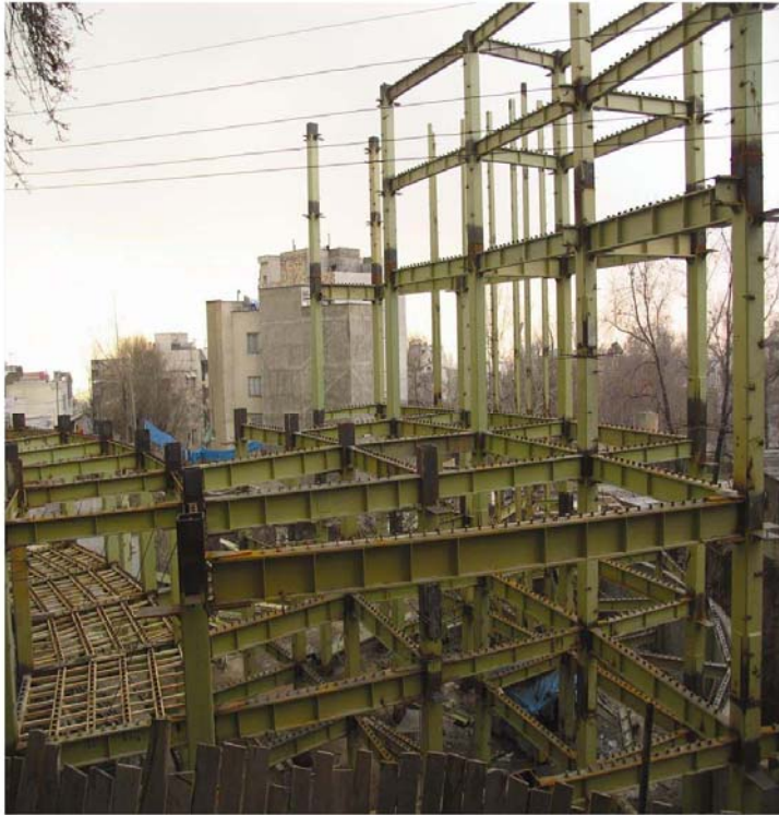
پروژه پارکینگ طبقاتی قاسمیه
