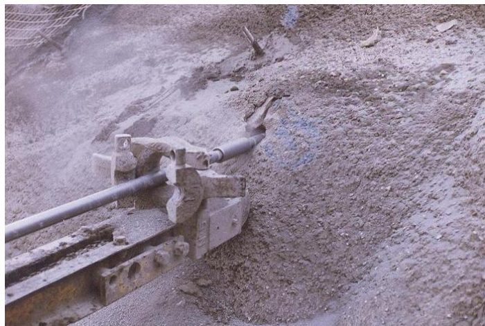
عملیات تحکیم لایه های سنگی و شات کریت
