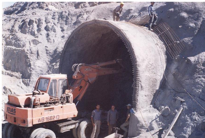
دهانه ورودی تونل انحراف آب سد گاران
