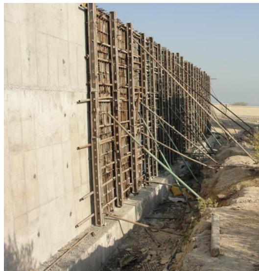
قالب بندی دیواره مخزن
