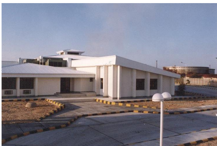
نمای جنوبی و ورودی اصلی شماره ۱ رستوران خارک
