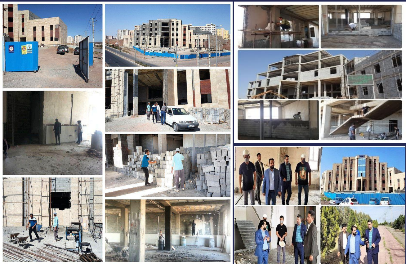
پروژه ساختمان مرکزی شهر جدید پرند
