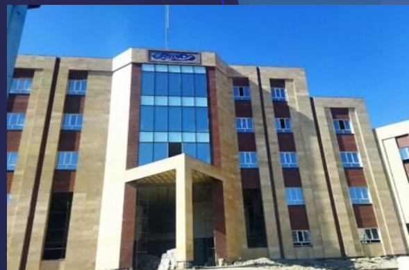
پروژه ساختمان مرکزی شهر جدید پرند
