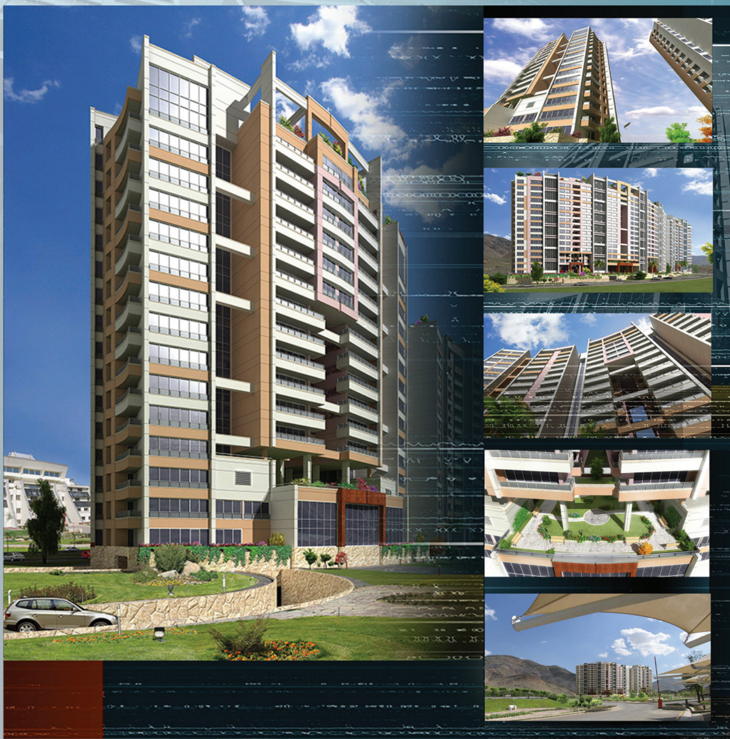
مجتمع مسکونی برج بهاران اراک
