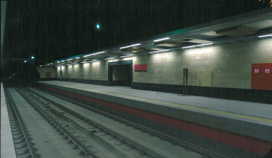
نمایی از ایستگاه شهران در خط ۶ مترو تهران
