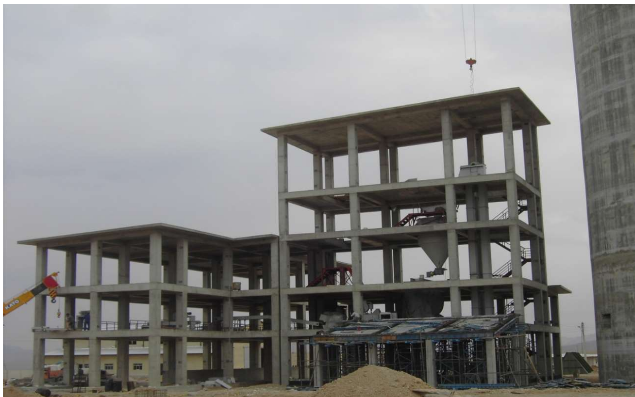
پروژه کارخانه سیمان ۲۲۰۰ تنی سیمان ساروج قسمتی از سایت
