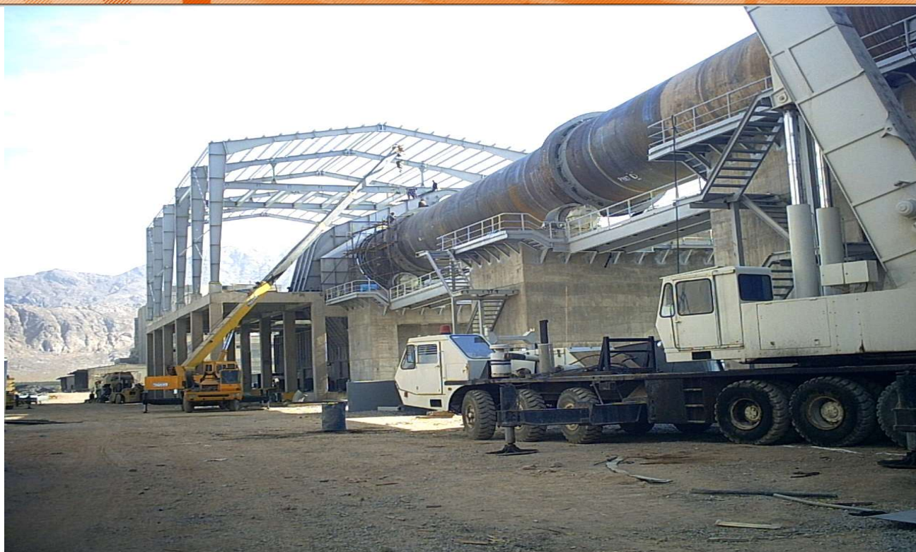
خط تولید سیمان ۳۳۰۰ تنی کارخانه سیمان سپاهان پایه های کوره گرید کولر واسکلت فلزی آن
