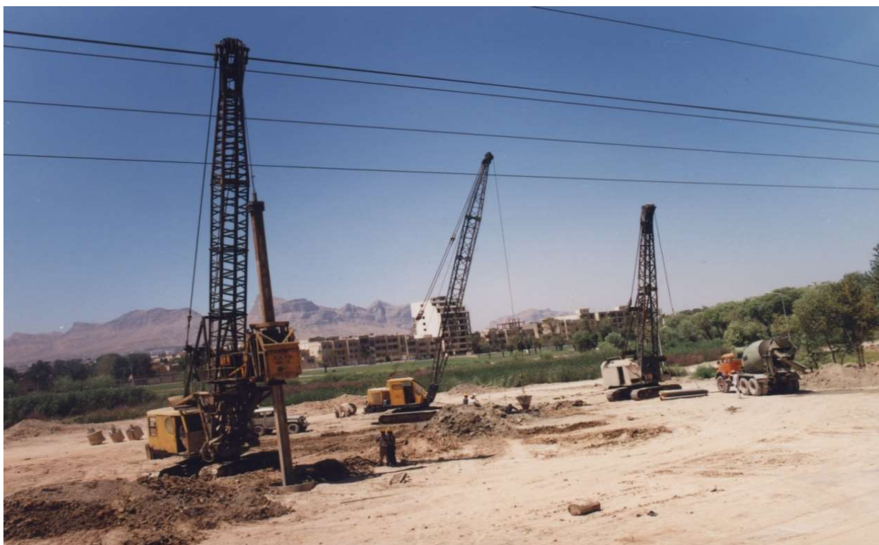
مجموعه پلهای غدیر اصفهان اجرای عملیات شمع ریزی
