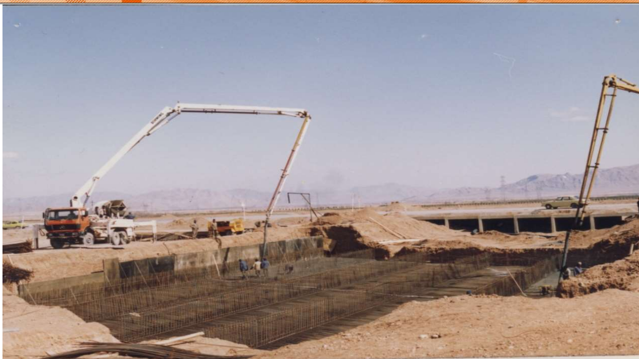
بلوار انبارها و بلوار پمپ خانه مجتمع فولاد مبارکه بتن ریزی یکی از پلها
