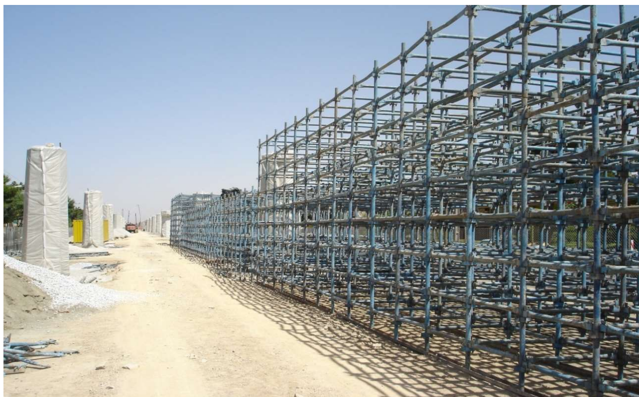
پل روگذر بزرگراه امام خمینی (ره) داربست های بسته شده جهت تیر طولی پل
