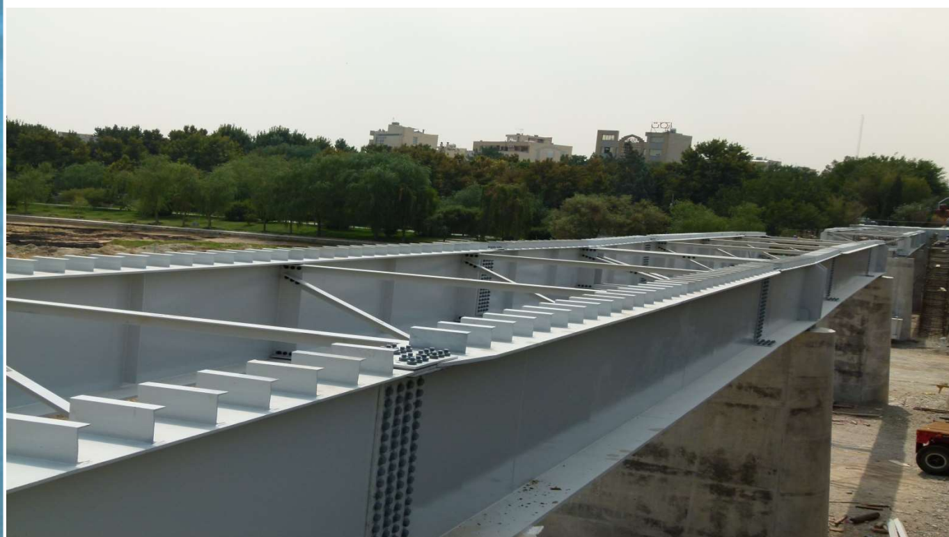
پل فلزی اصفهان تیرهای نصب شده پل
