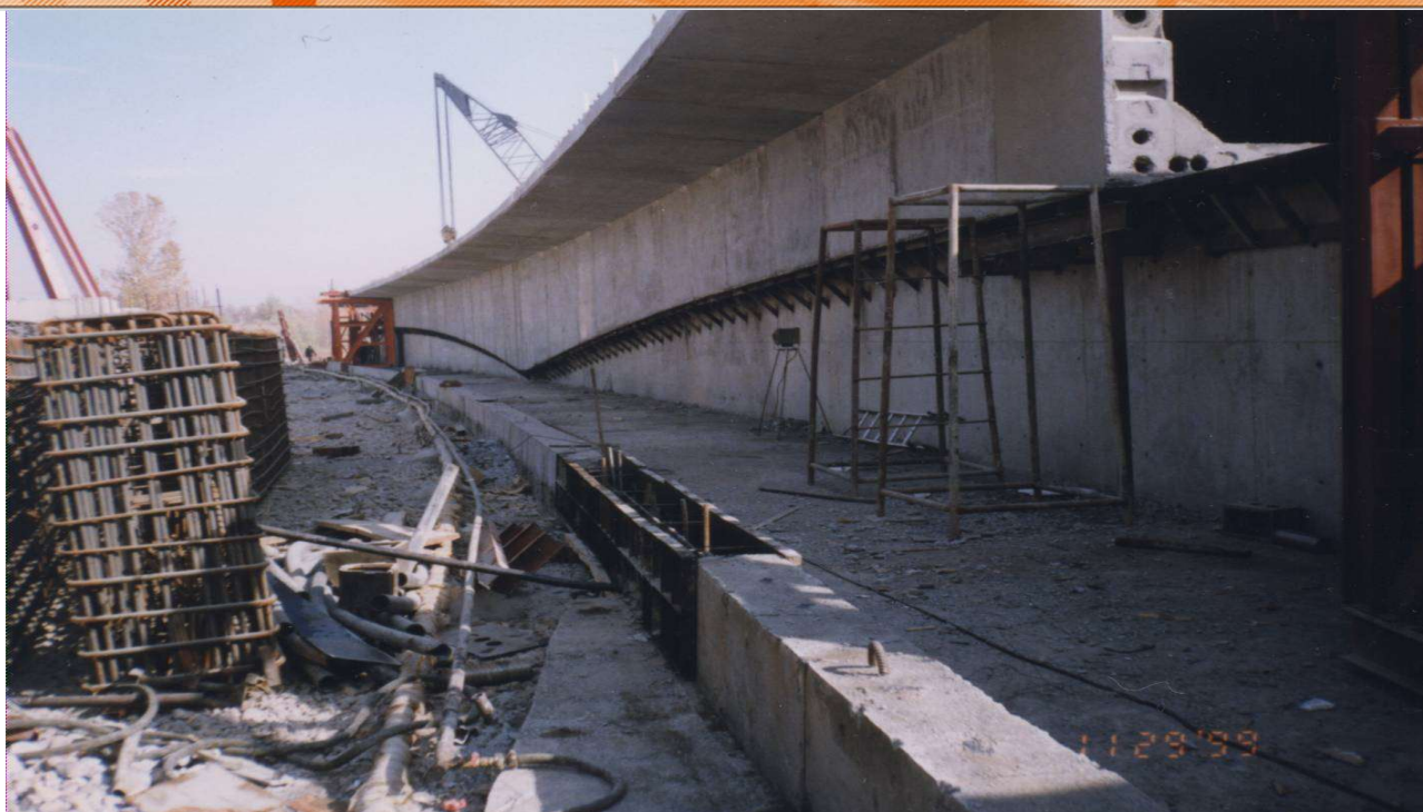
مجموعه پلهای غدیر اصفهان قطعات صندوقه‌ای پیش ساخته روی پد بتنی با قالب مخصوص متحرک که در ابتدا و انتهای عکسها برنگ قرمز مشخص شده
