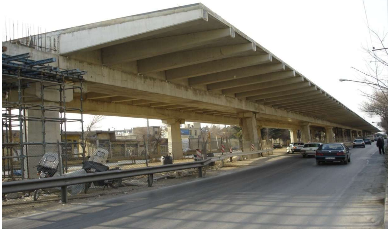
پل روگذر بزرگراه امام خمینی (ره) نماایی از عرشه پل
