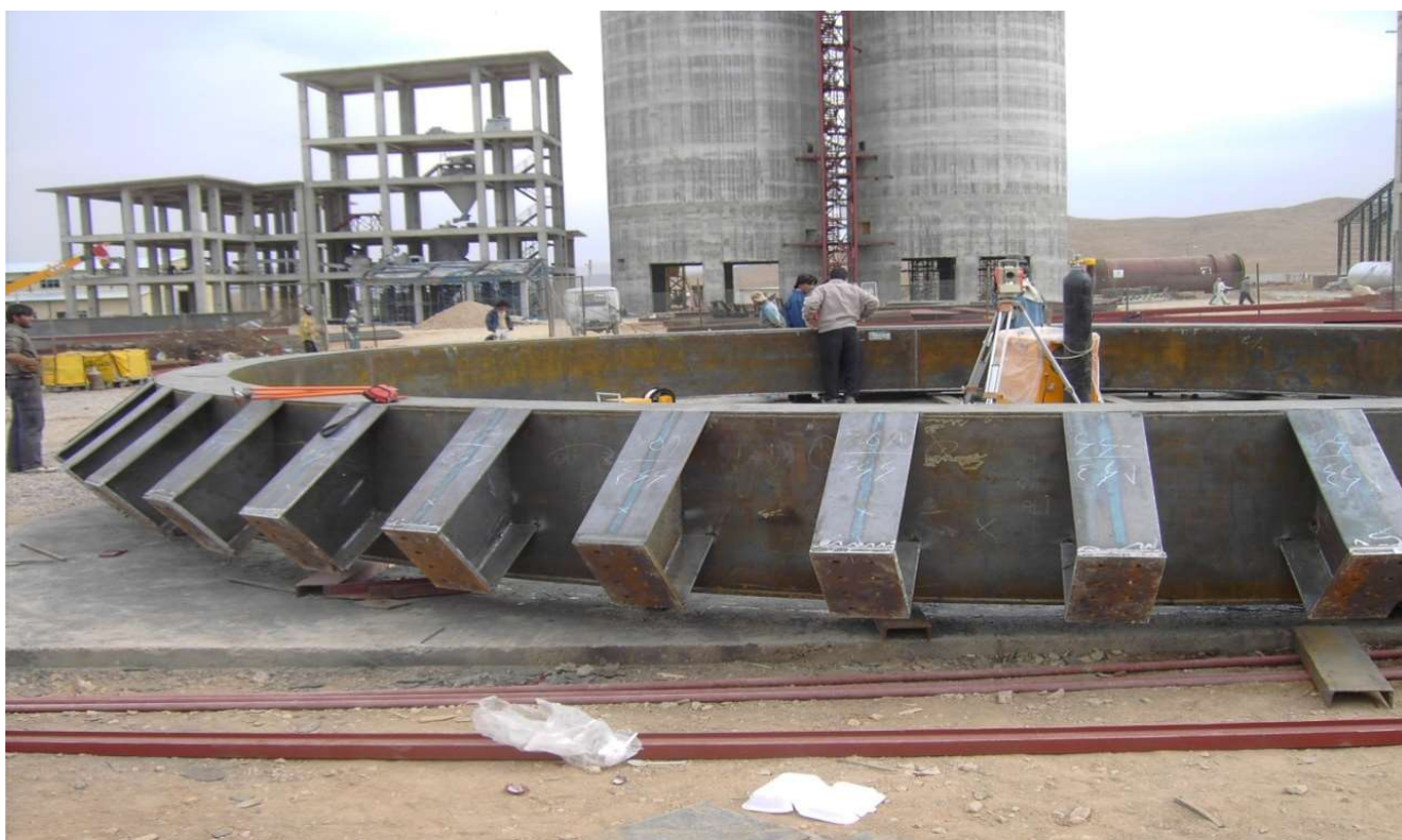
کارخانه سیمان ۲۲۰۰ تنی سیمان ساروج اسکلت فلزی رینگ بالای سیلوی کلینکر و نصب در ارتفاع ۴۰ متری
