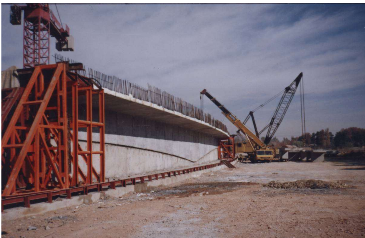
مجموعه پلهای غدیر اصفهان قطعات صندوقه‌ای پیش ساخته روی پد بتنی با قالب مخصوص متحرک که در ابتدا و انتهای عکسها برنگ قرمز مشخص شده
