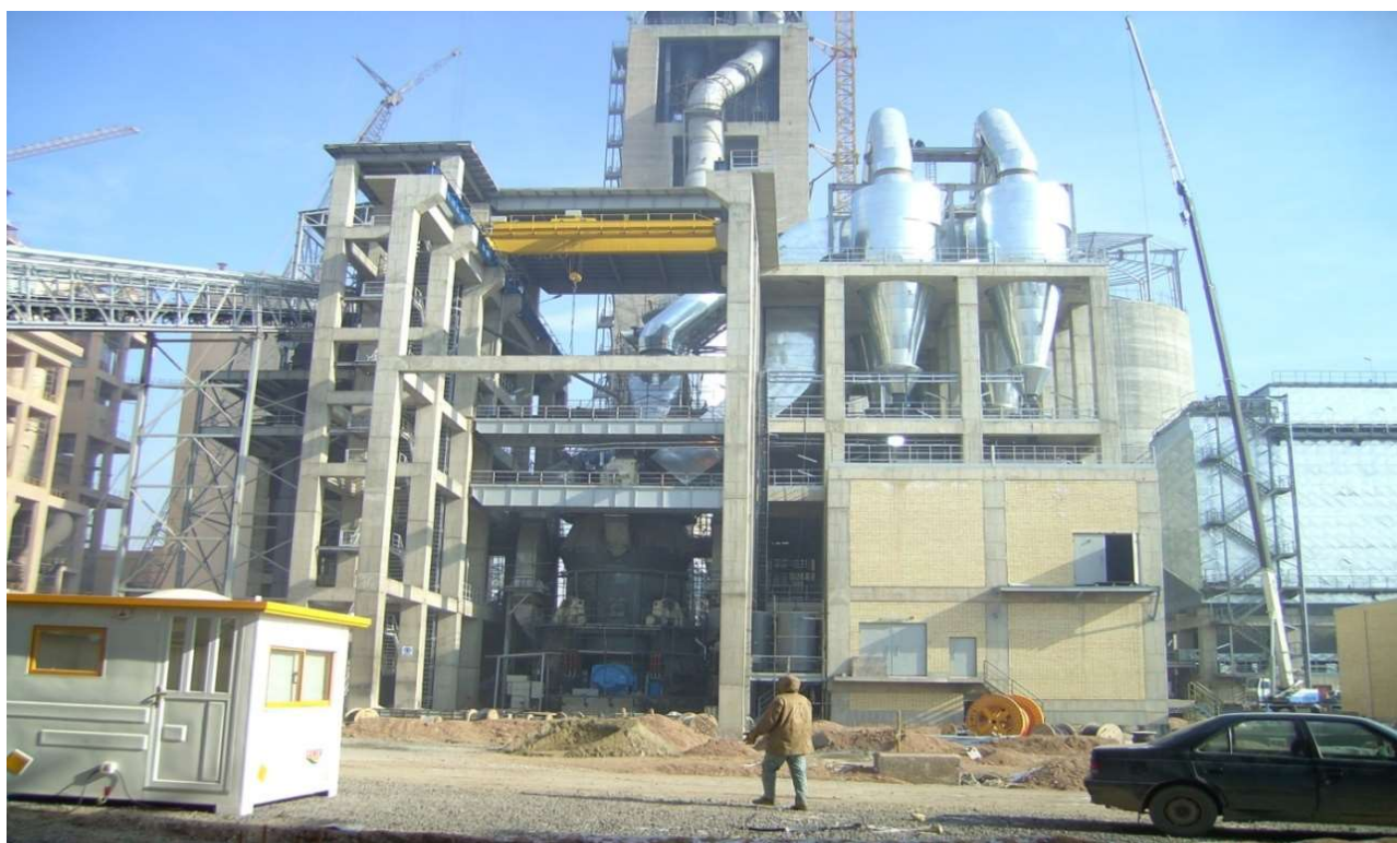
خط تولید سیمان ۳۳۰۰ تنی کارخانه سیمان سپاهان برج پری هیتز ، سیلوهای مواد و آسیاب مواد ...
