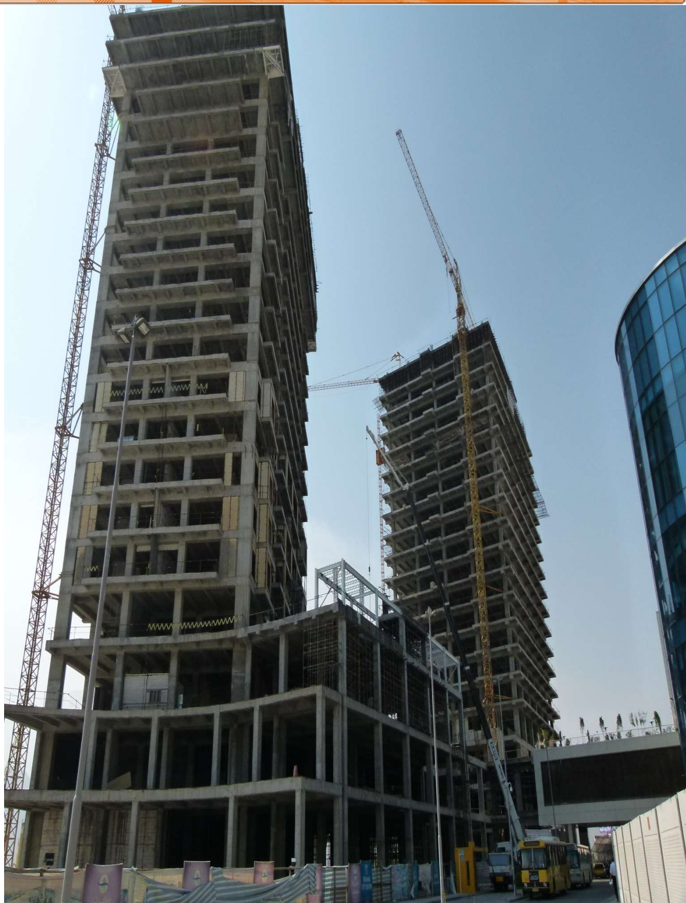
برجهای مسکونی IFC1 و اداری IFC5 و مجموعه رفاهی IFC3 سیتی سنتر در حال ساخت
