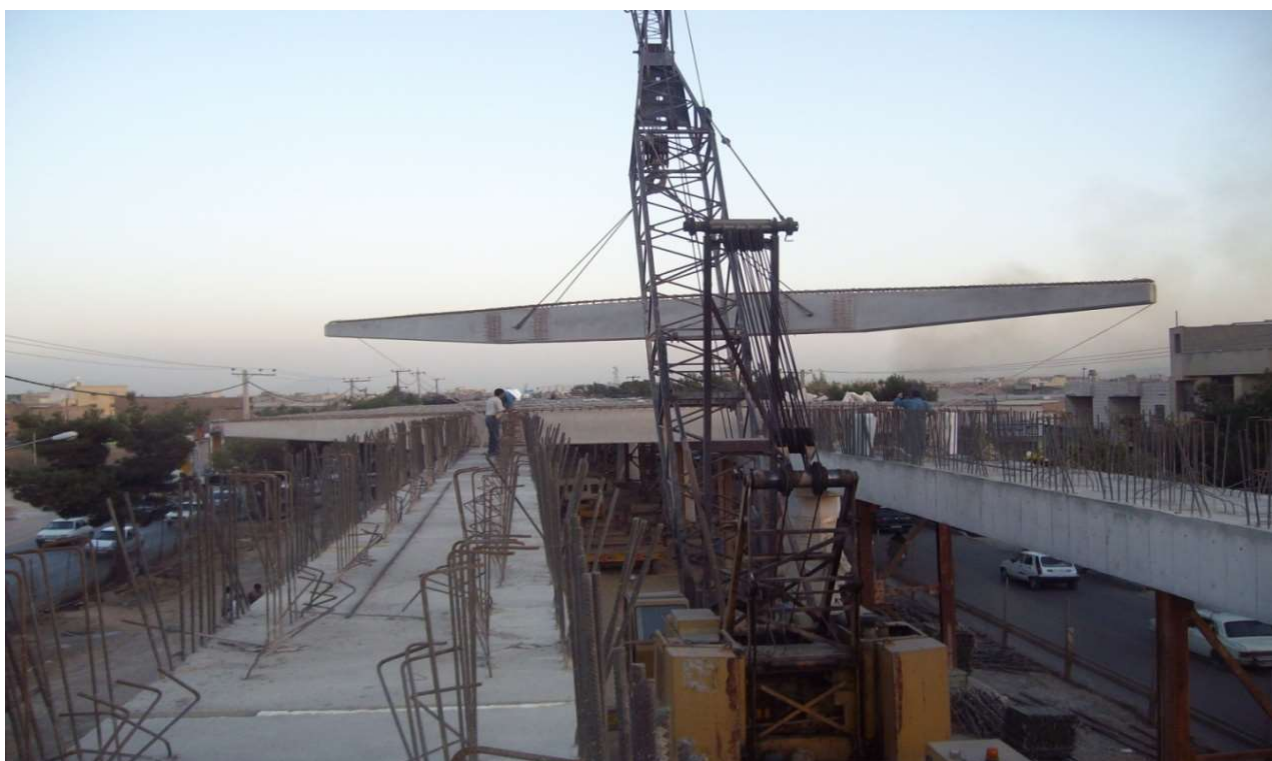
پل روگذر بزرگراه امام خمینی (ره) نصب تیرهای عرضی پل در حال ترده عادی روزانه
