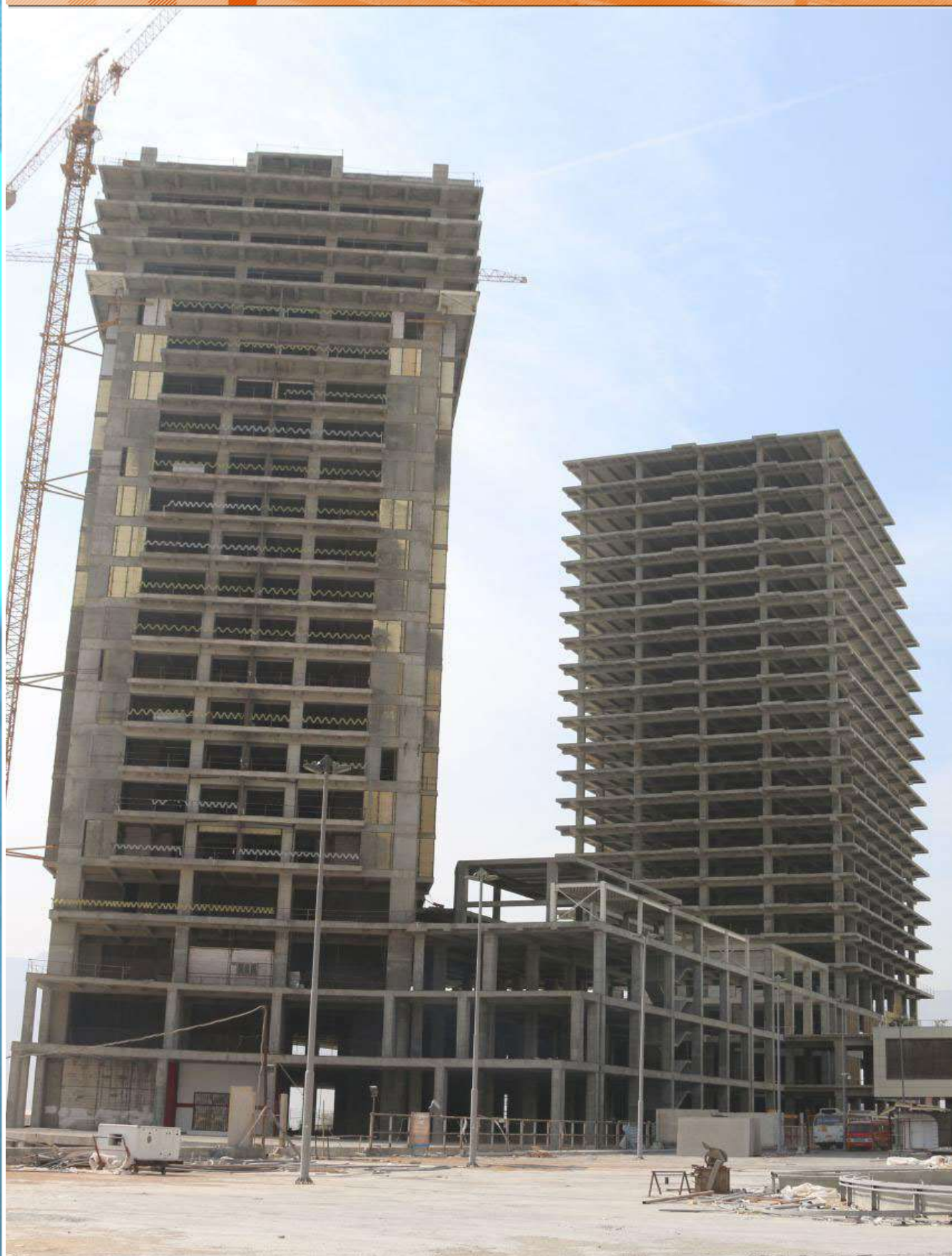
برجهای مسکونی IFC1 و اداری IFC5 و مجموعه رفاهی IFC3 سیتی سنتر در حال ساخت
