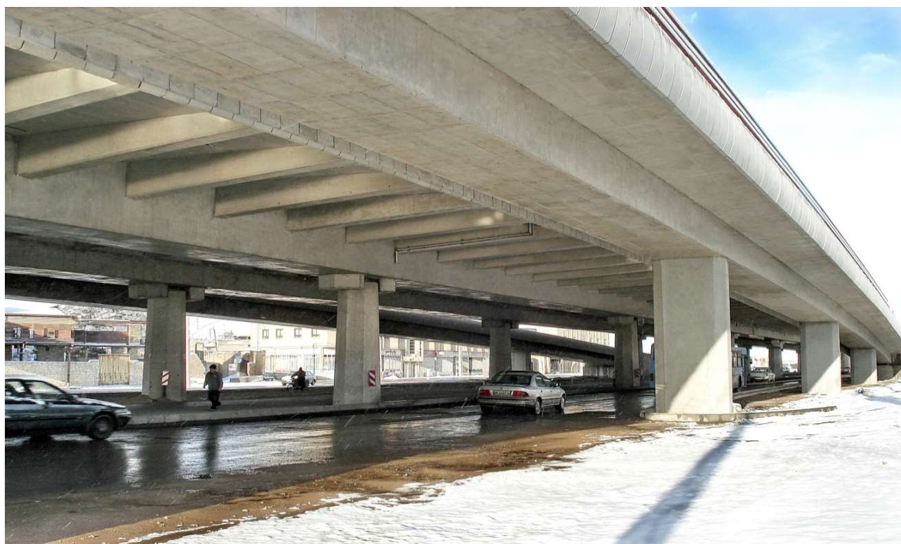
پل روگذر بزرگراه امام خمینی (ره) نمای زیر پل و رمپ‌های ورودی و خروجی
