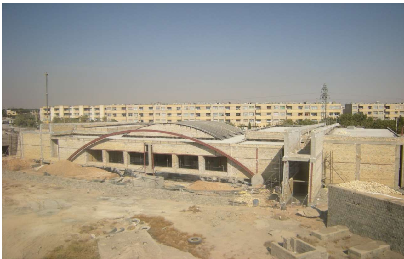
ایستگاه مترو قدس
