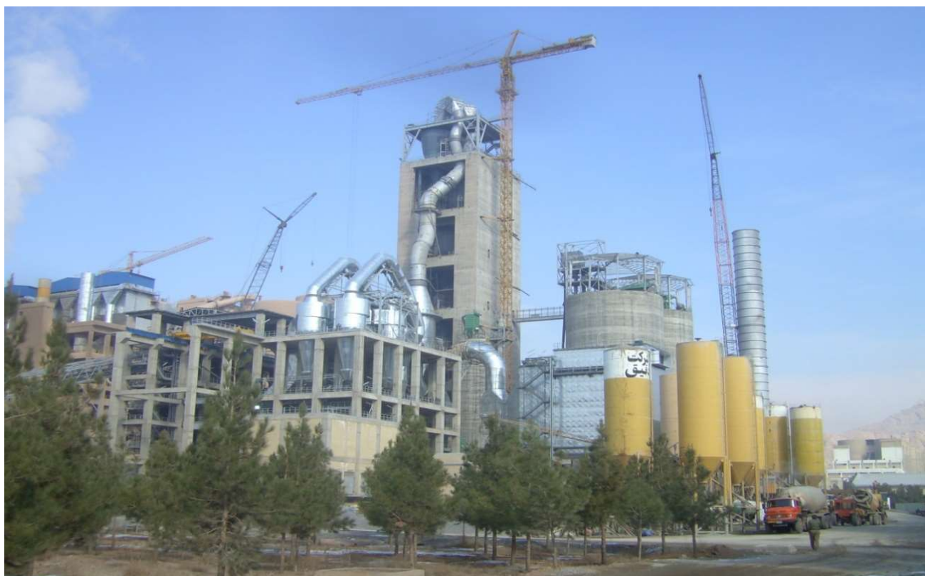
خط تولید سیمان ۳۳۰۰ تنی کارخانه سیمان سپاهان اجرای برج پری هیتر به ارتفاع ۹۲ متر وسیلوهاوگریدر کولر و سازه فلزی آن
