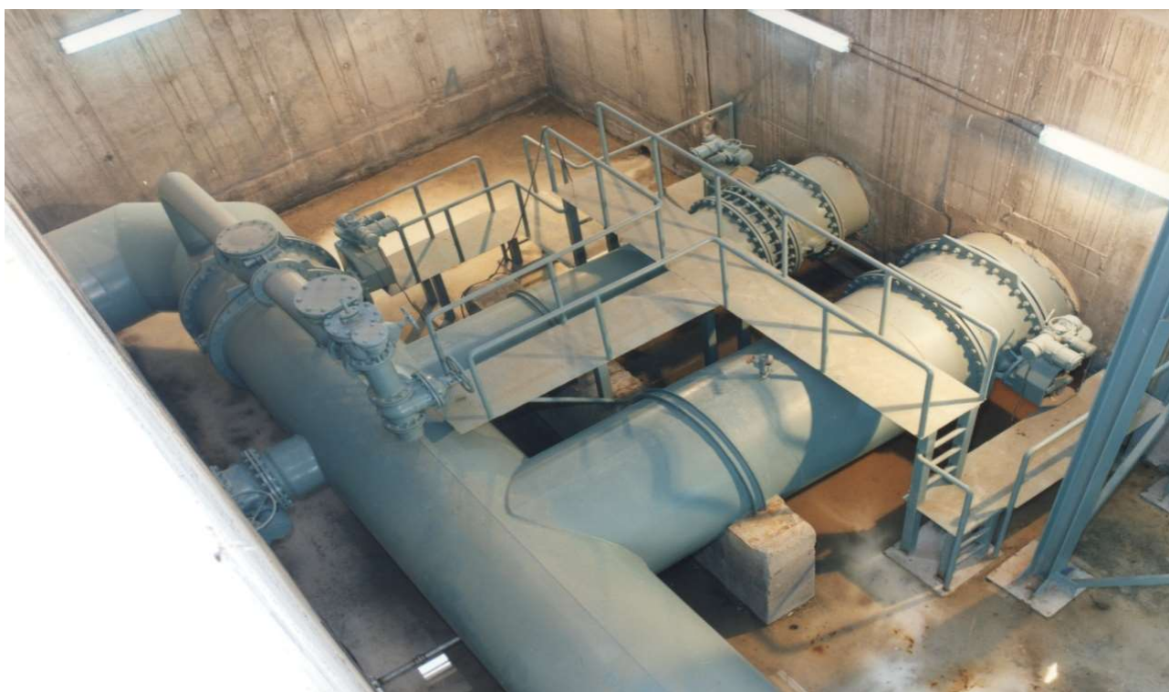
منبع آب ۷۰,۰۰۰ مترمکعبی در شرق اصفهان نمای داخلی ساختمان و تاسیسات شیرخانه
