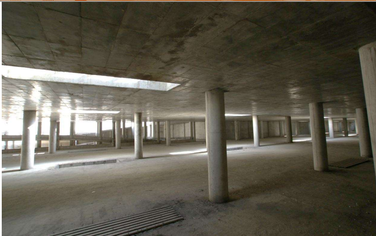
پروژه روگذر، زیرگذر و پارکینگ خیابان گلدسته طبقه ۲- پارکینگ
