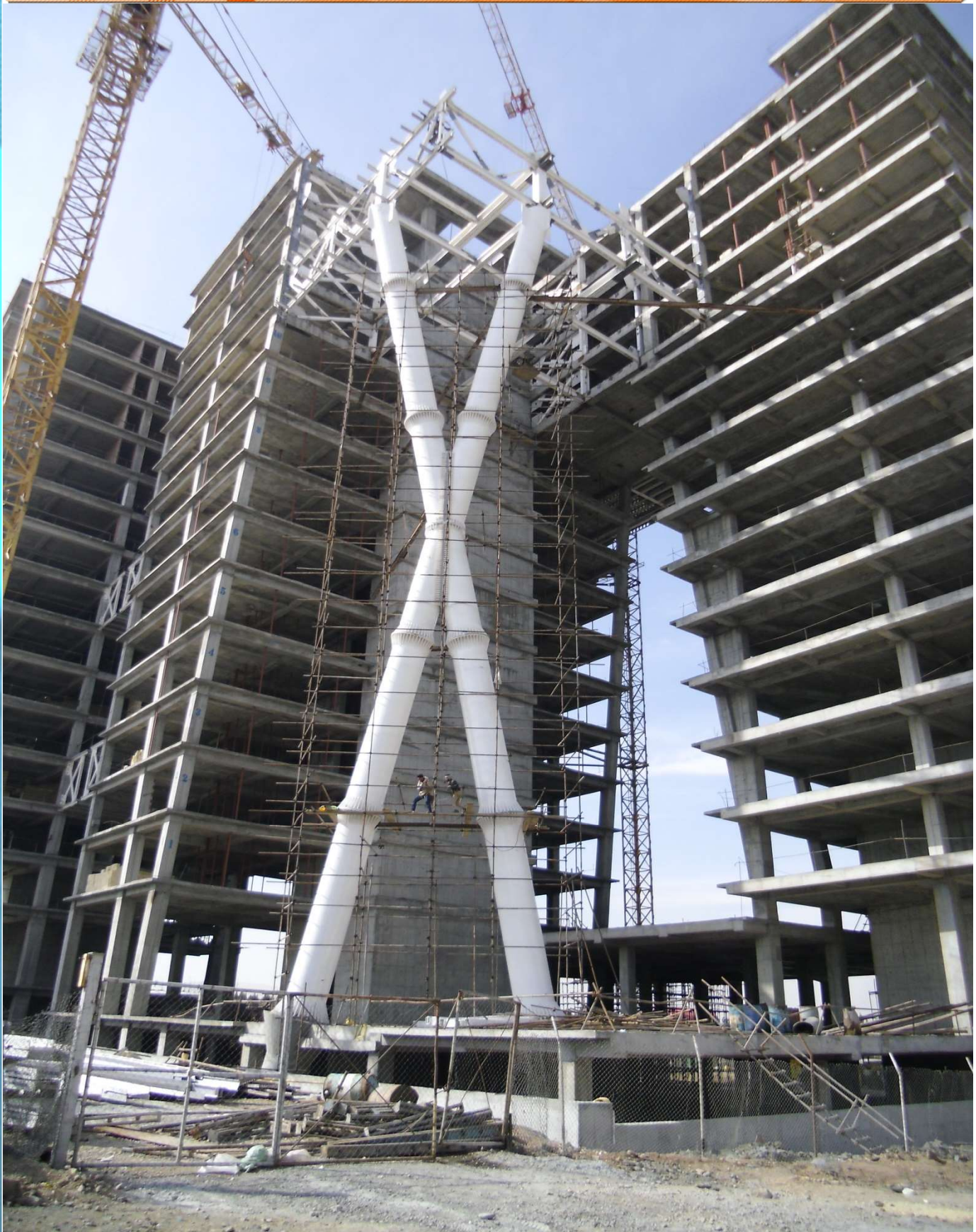
مجتمع مسکونی آبشار نصب اسکلت فلزی طبقات بر روی سازه ایکس
