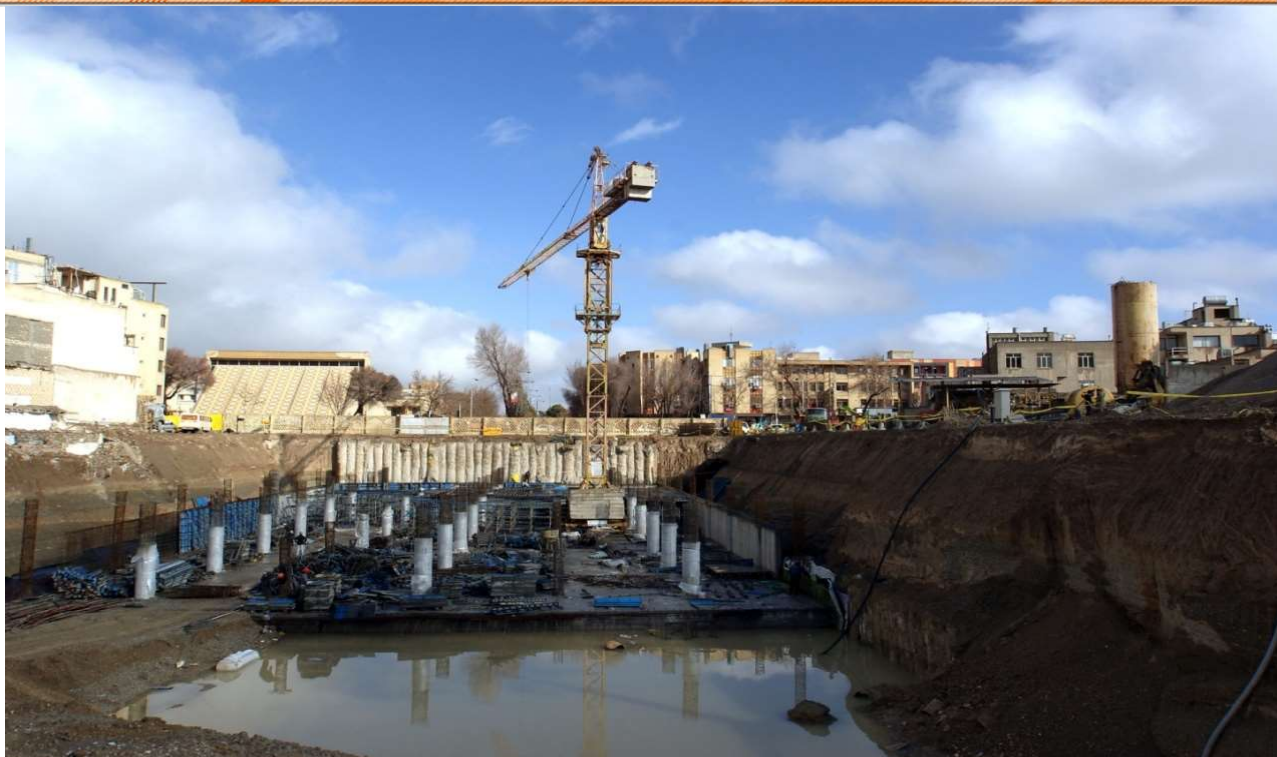
پروژه روگذر، زیرگذر و پارکینگ خیابان گلدسته در حال قالببندی و جمع آوری آبهای زیرزمینی به علت اینکه پروژه در مسیر آبهای زیرزمینی بوده و زمین پروژه از نوع شن و ماسه رودخانه ای میباشد
