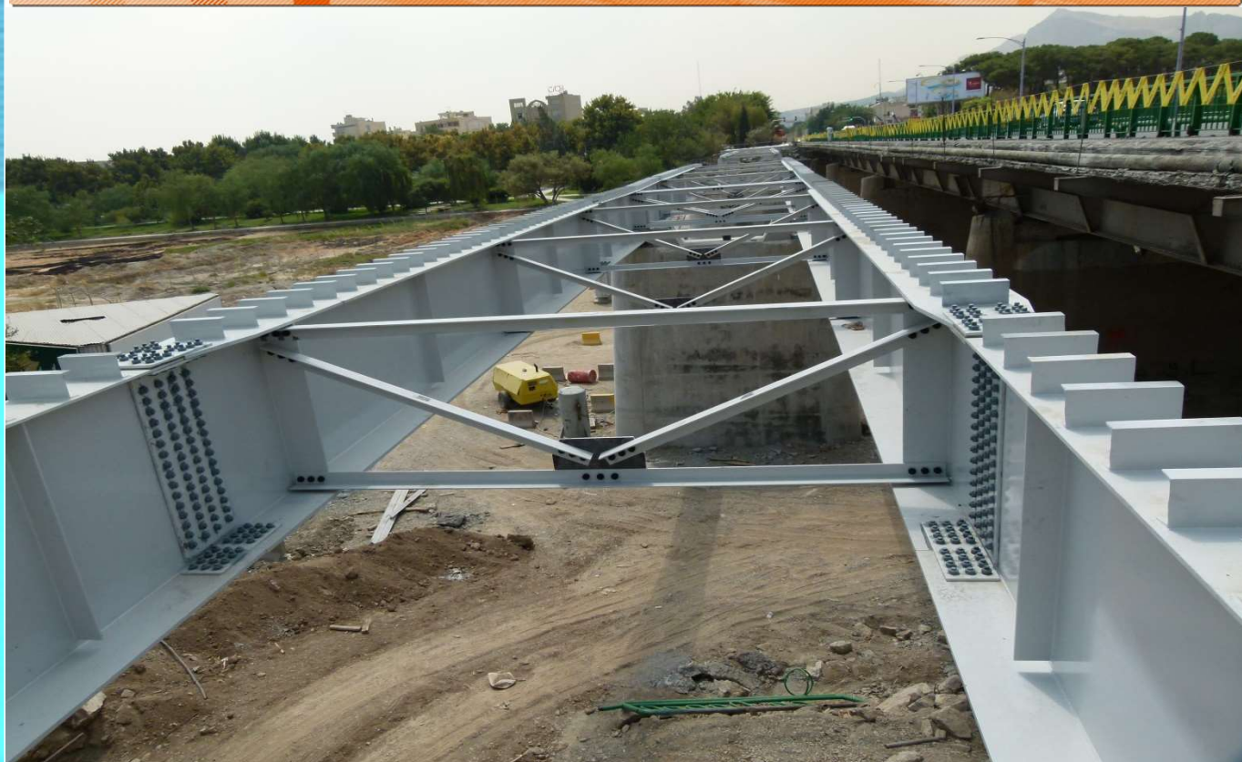
پل فلزی اصفهان تیرهای نصب شده پل
