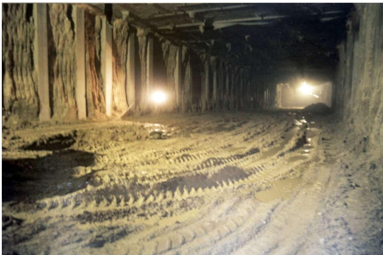
متروی شمالی اصفهان حفاری تونل
