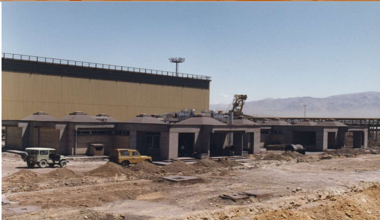
ساختمان پناهگاه و رختکنهای مجتمع فولاد مبارکه نمای بیرونی
