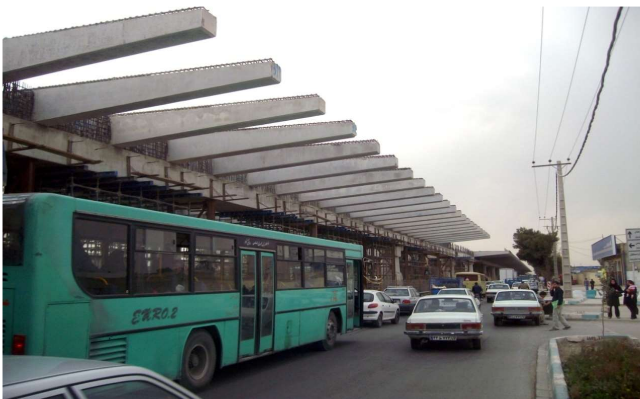
پل روگذر بزرگراه امام خمینی (ره) نمای طولی پل و ساخت پل در حال ترده عادی روزانه
