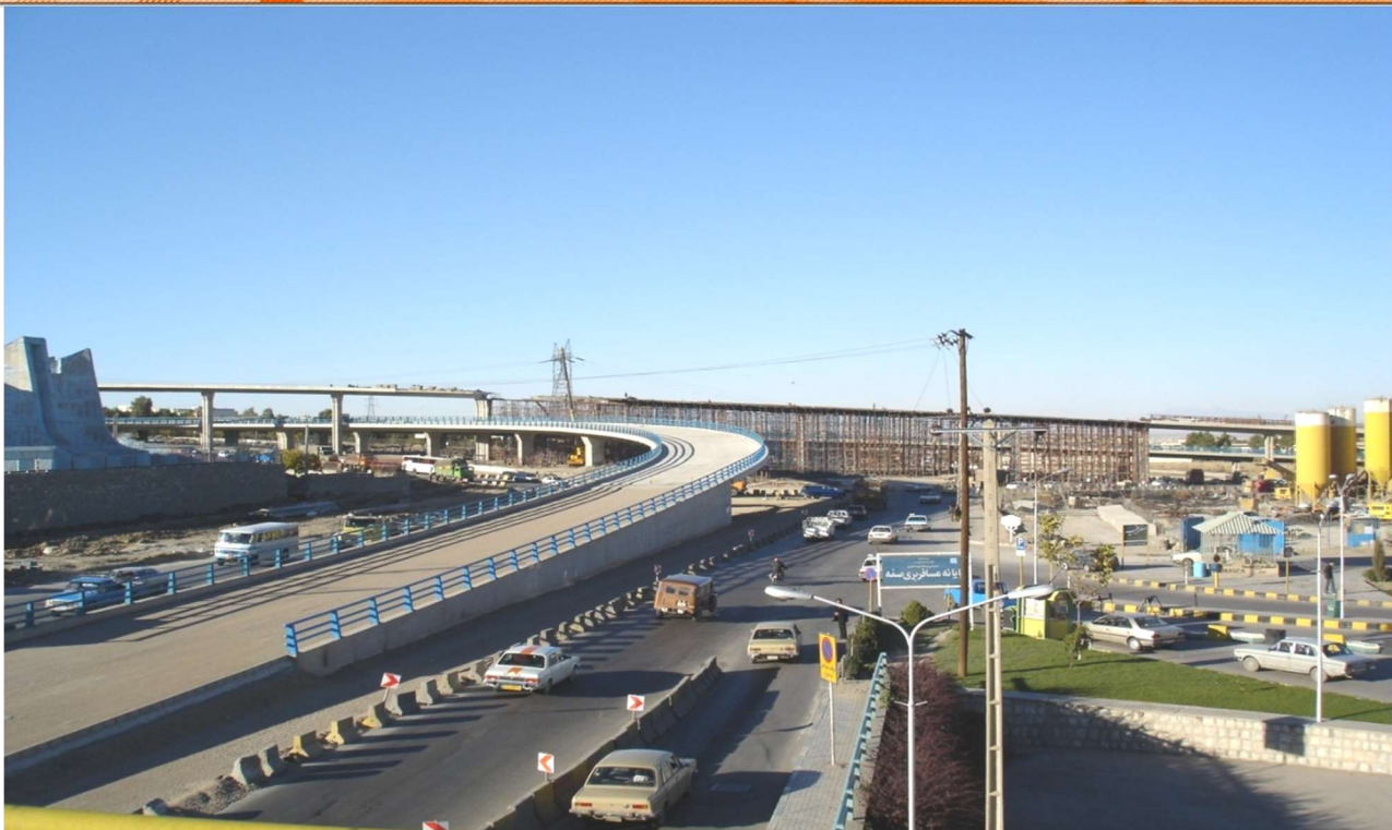
تقاطع غیر همسطح دفاع مقدس پل ۳۰۰ در حال ساخت و ۲۰۰ تکمیل شده
