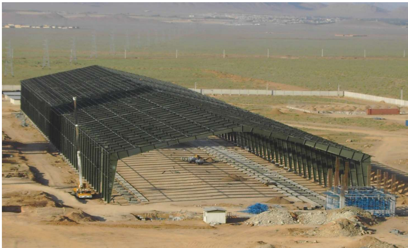
پروژه کارخانه سیمان ۲۲۰۰ تنی سیمان ساروج سالن خاک
