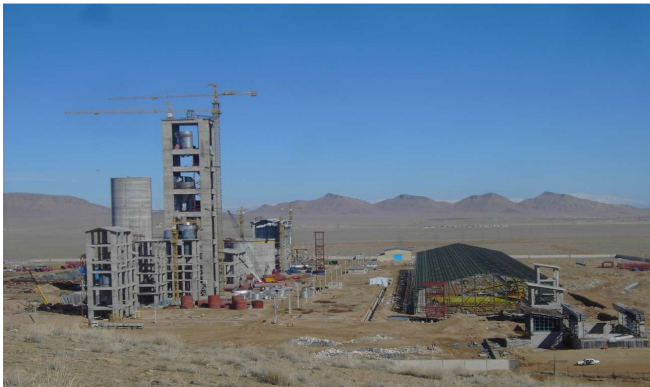
پروژه کارخانه سیمان ۲۲۰۰ تنی سیمان ساروج قسمتی از سایت شامل: سیلوها ، برج پری هیتز، آسیاب مواد و...
