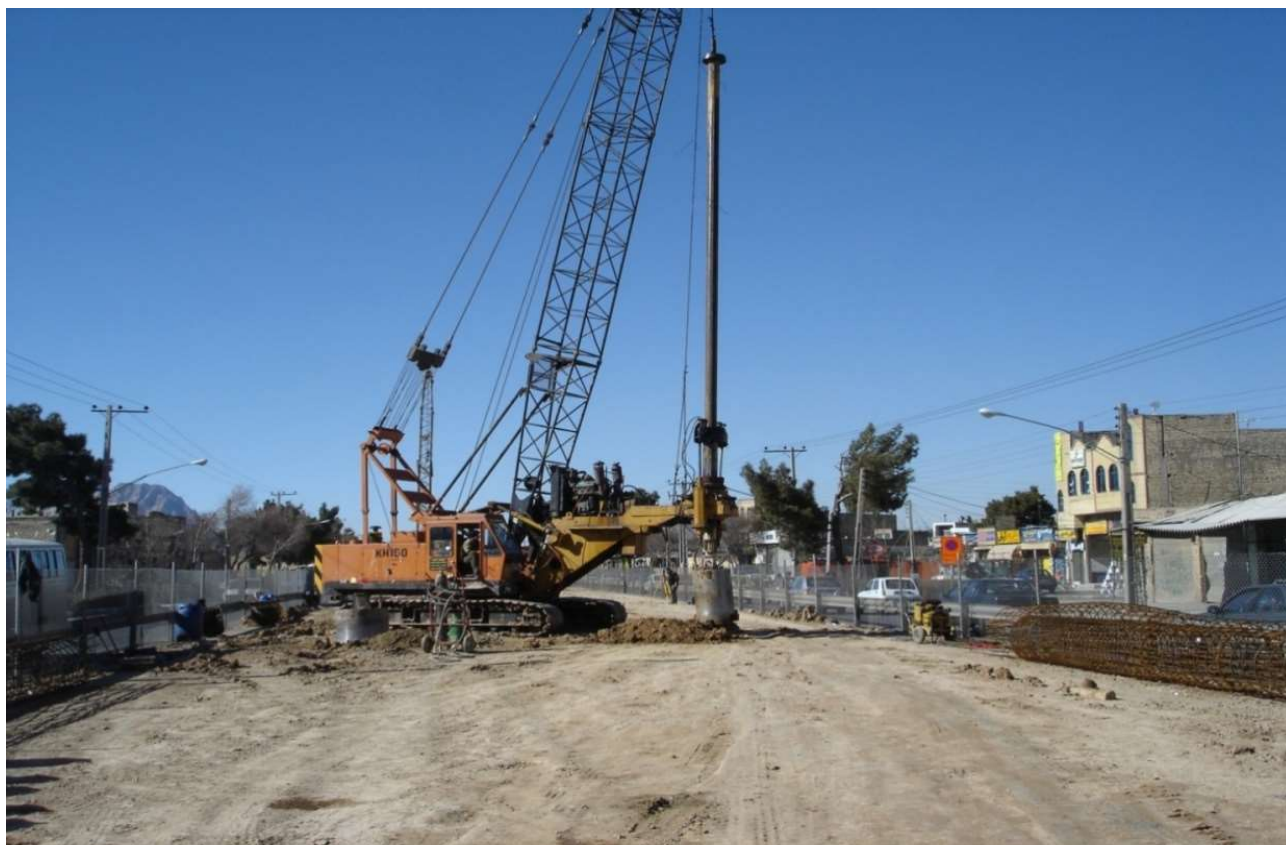
پل روگذر بزرگراه امام خمینی (ره) دستگاه حفار در حال شمع زنی
