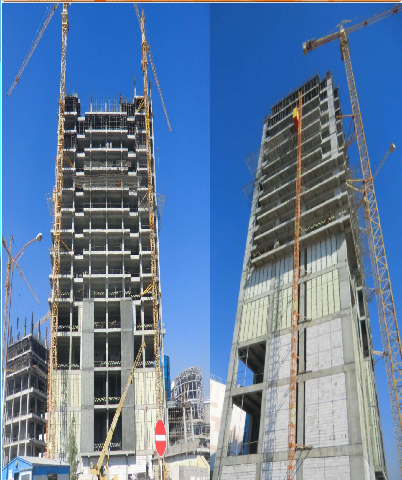
برج ۲۷ طبقه مسکونی سیتی سنتر در حال ساخت
