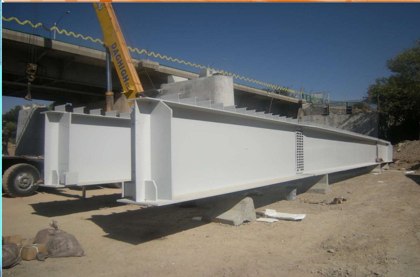
پل فلزی اصفهان نصب تیرهای فلزی پل
