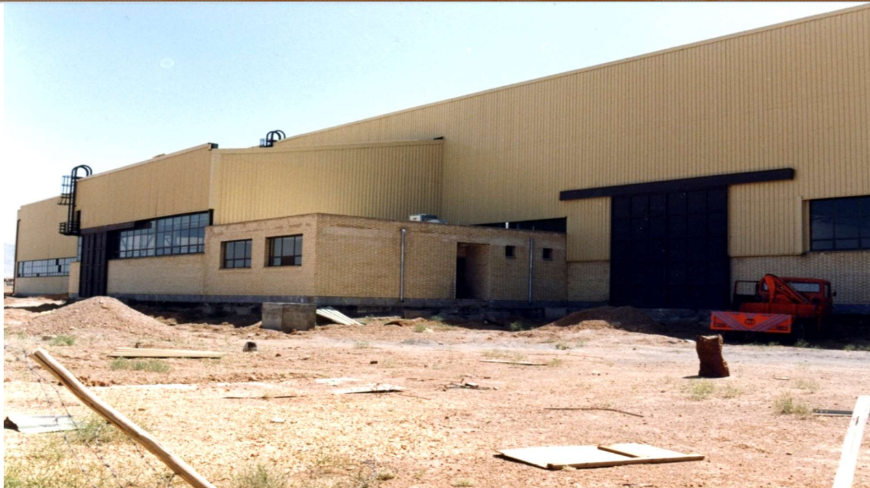
ساختمان تعمیرگاه ترانسفورماتور مجتمع فولاد مبارکه نمای خارجی
