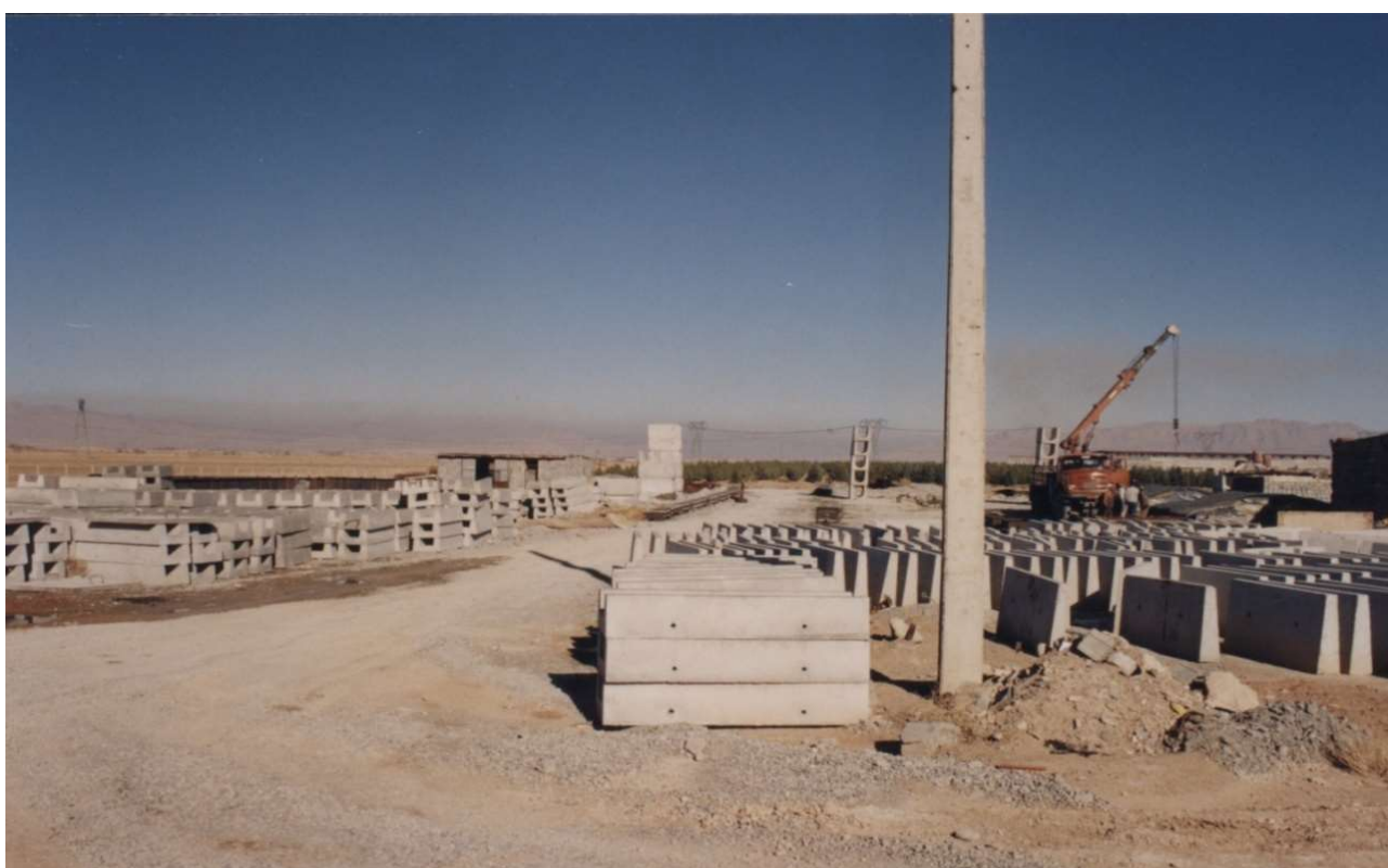
بلوار انبارها و بلوار پمپ خانه مجتمع فولاد مبارکه کارگاه تولید قطعات جداول و کانیهای پیش ساخته
