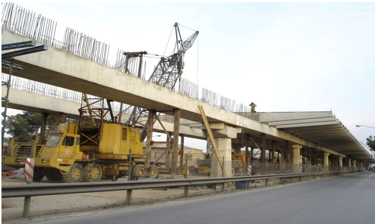
پل روگذر بزرگراه امام خمینی (ره) جرقیل ۱۴۰ تن در حال نصب تیرها
