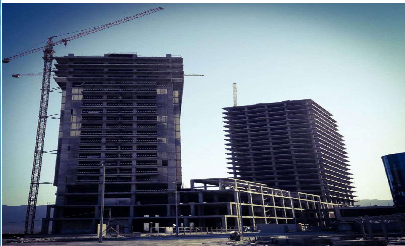
برجهای مسکونی IFC1 و اداری IFC5 و مجموعه تجاری IFC4 سیتی سنتر در حال ساخت
