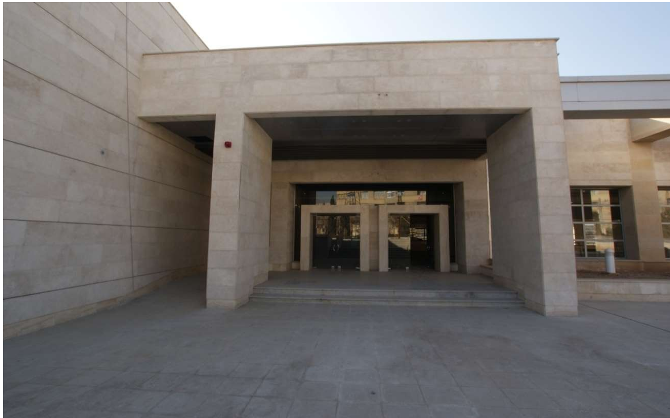
ایستگاه مترو قدس
