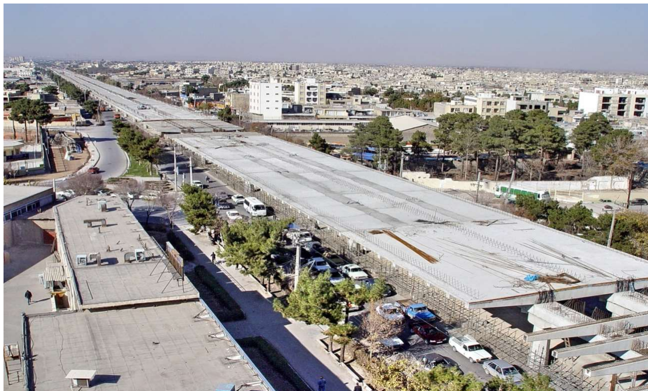
پل روگذر بزرگراه امام خمینی (ره) نمای طولی پل و ساخت پل در حال ترده عادی روزانه
