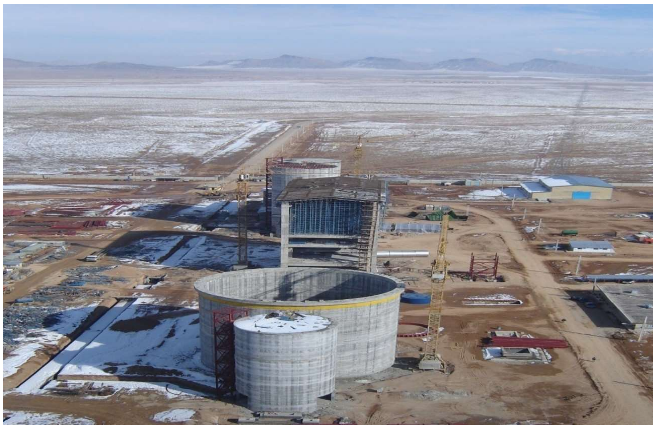
سایت پروژه کارخانه سیمان ۲۲۰۰ تنی سیمان ساروج
