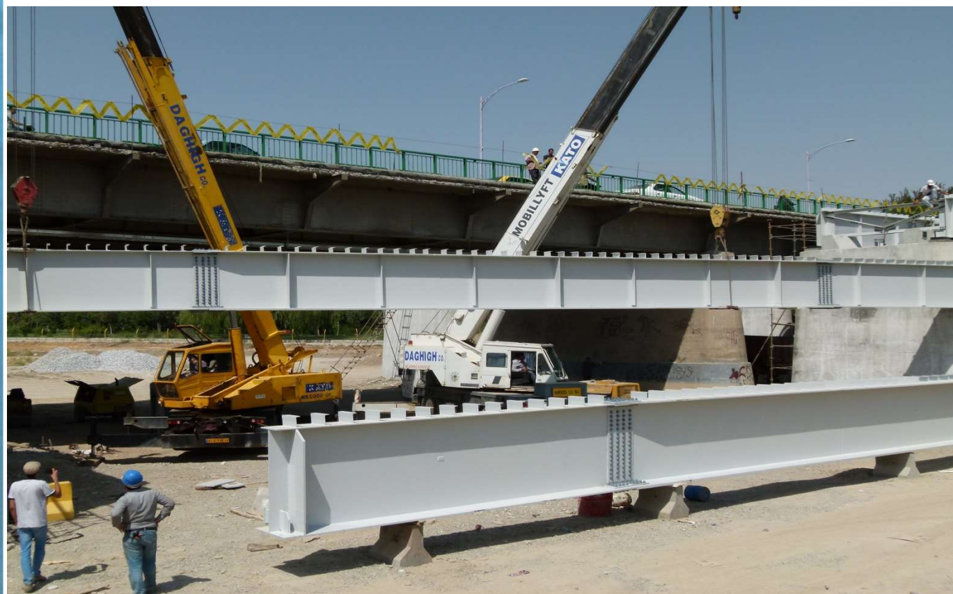
پل فلزی اصفهان نصب تیرهای فلزی پل
