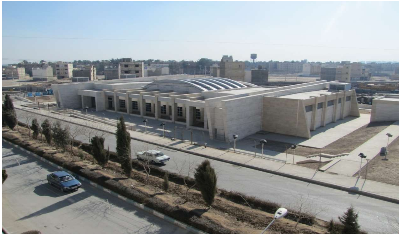
ایستگاه مترو قدس
