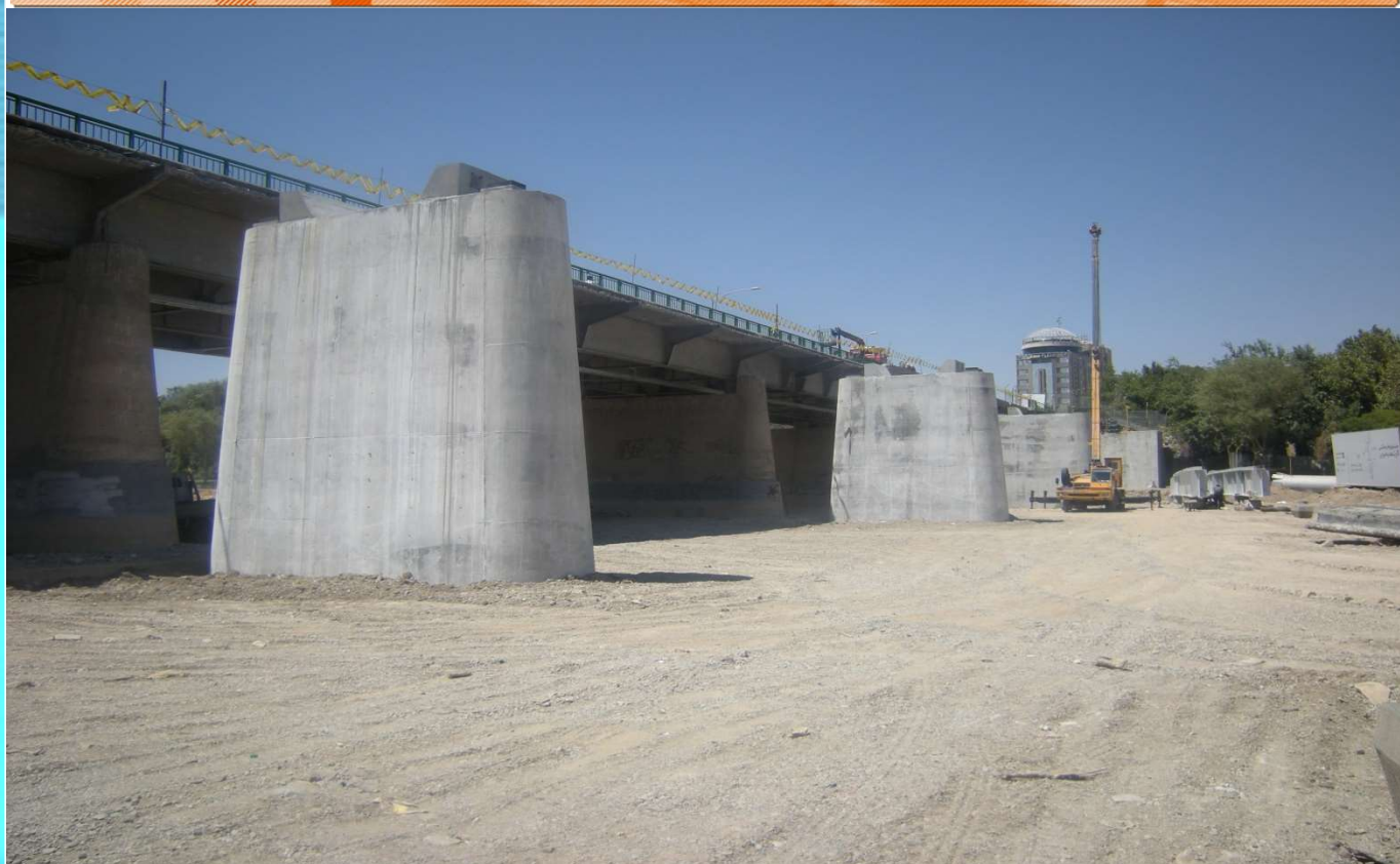
پل فلزی اصفهان ستونهای پــــل
