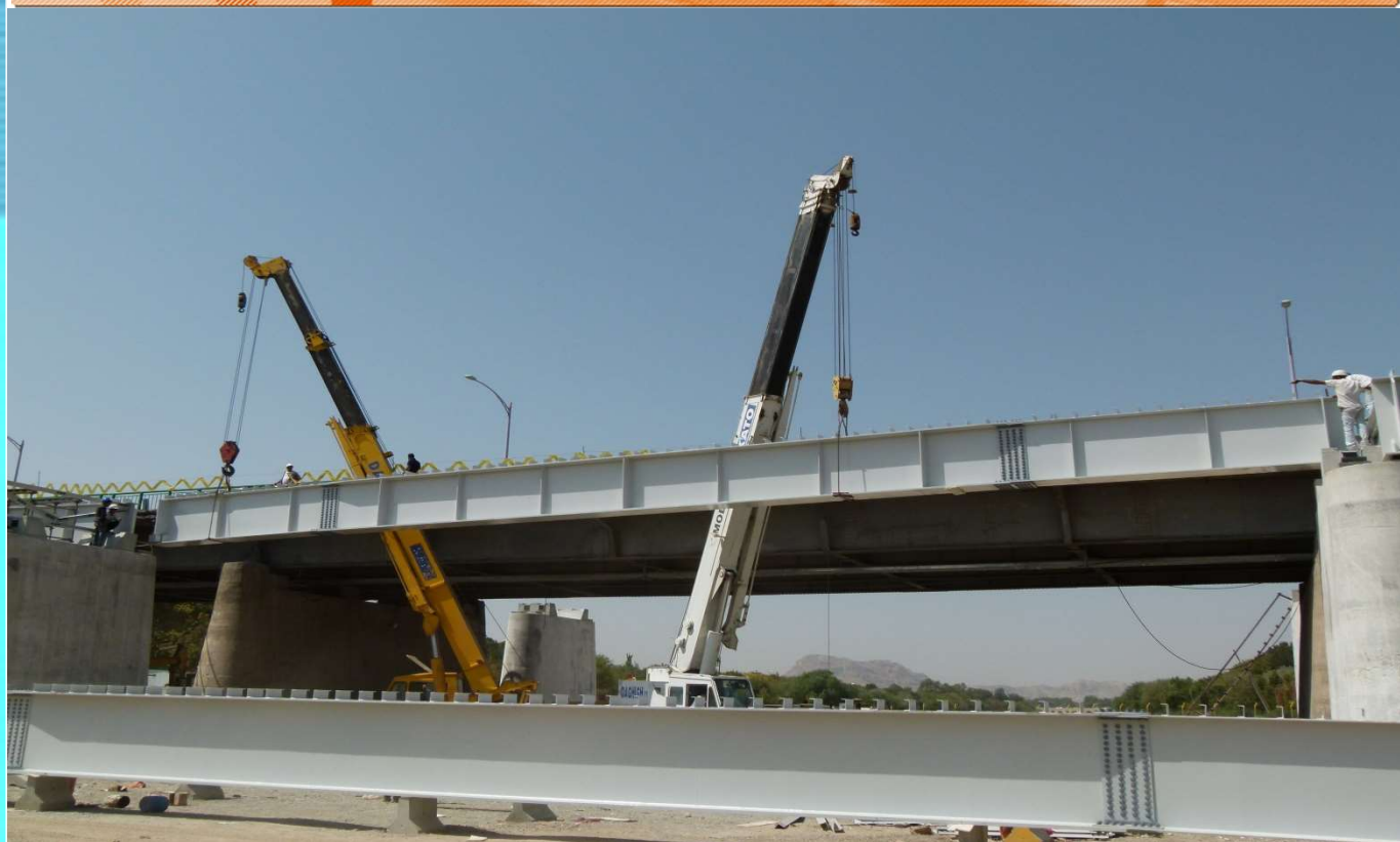
پل فلزی اصفهان ستونهای پـــــــل
