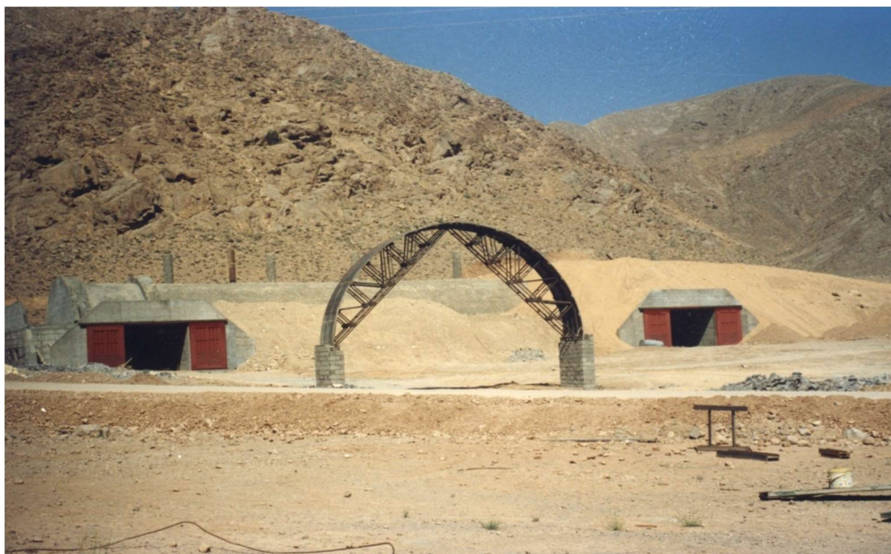
کارخانجات مجتمع صنعتی هفتم تیر نحوه قالببندی
