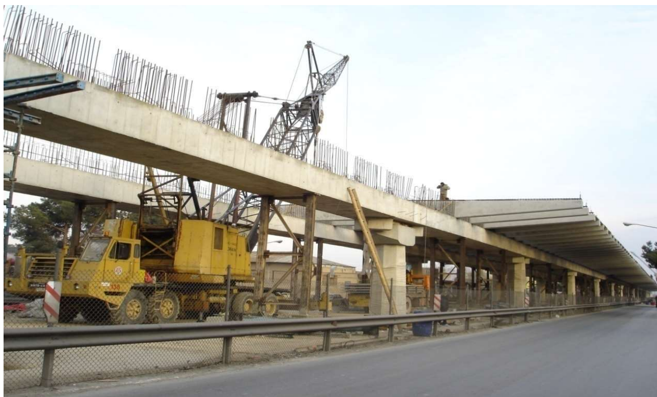
پل روگذر بزرگراه امام خمینی (ره) جرثقیل ۱۴۰ تن در حال نصب تیرها در حال ترده عادی روزانه
