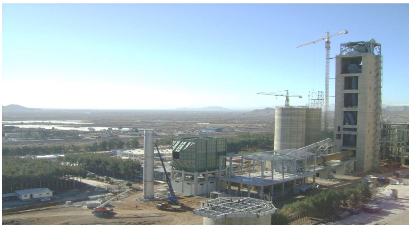
خط تولید سیمان ۳۳۰۰ تنی کارخانه سیمان سپاهان اجرای برج پری هیتز به ارتفاع ۹۲ متر و سیلوها و گریدر کوئلر و سازه فلزی آن
