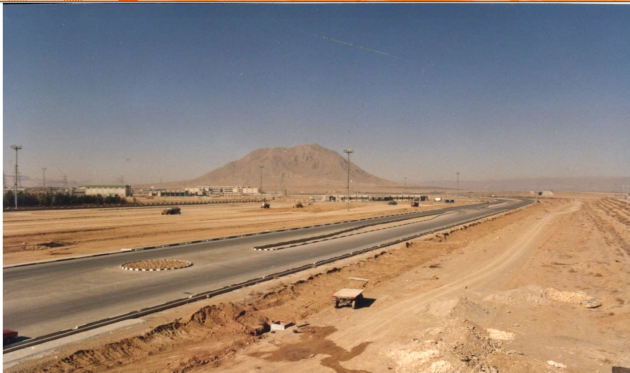
بلوار انبارها و بلوار پمپ خانه مجتمع فولاد مبارکه قسمتی از پروژه بلوار
