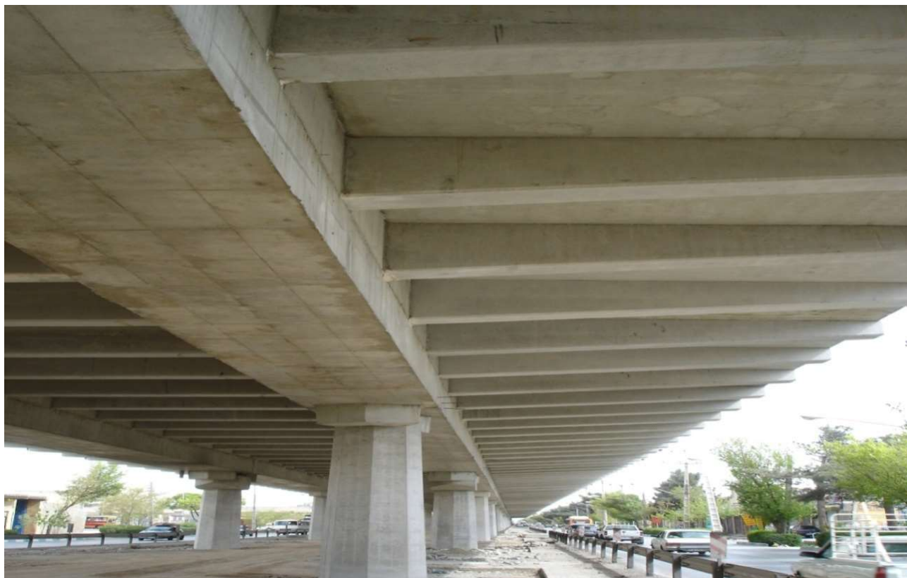
پل روگذر بزرگراه امام خمینی (ره) نمای کنسول کناری پل
