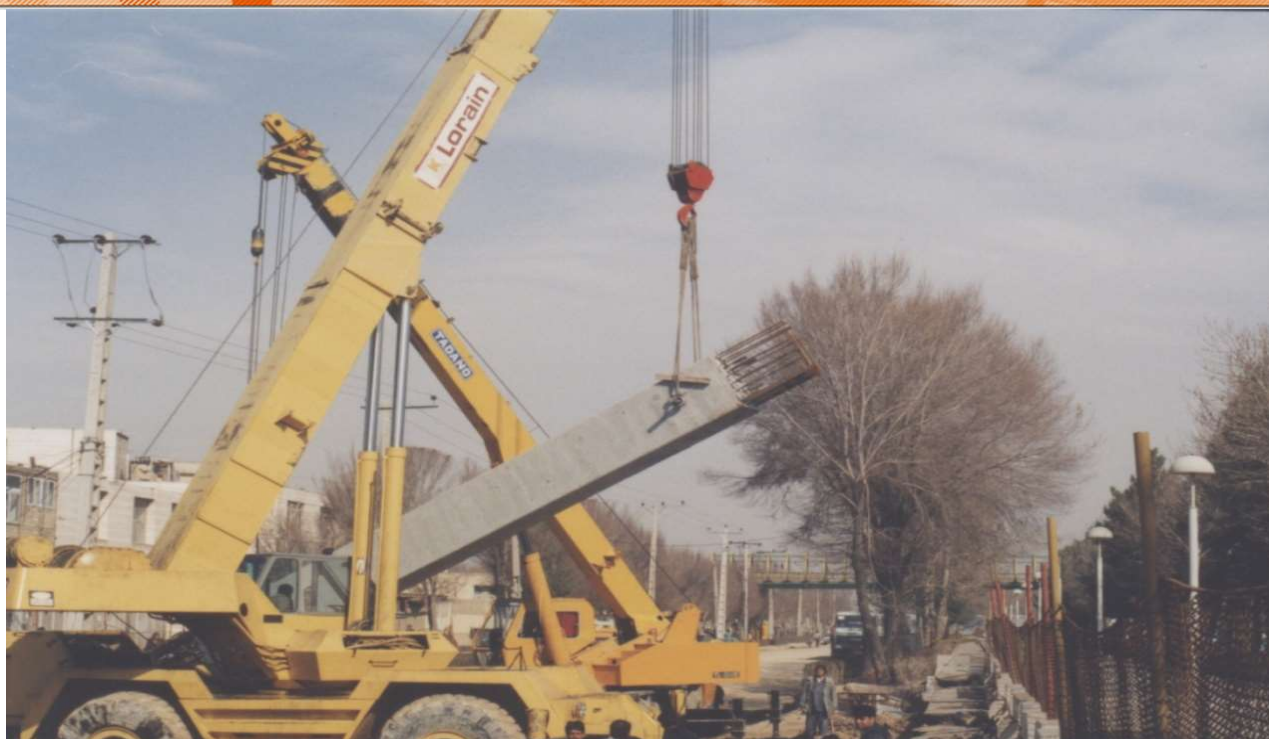
متروی اصفهان قطعه شمالی نصب ستونهای پیش ساخته تونل تا ۱۵ تن وزن و ۱۴ متر طول
