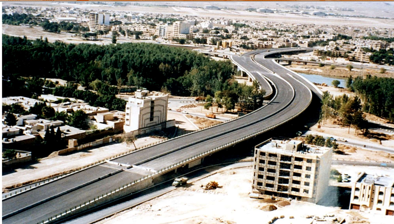
مجموعه پلهای غدیر عکس هوایی
