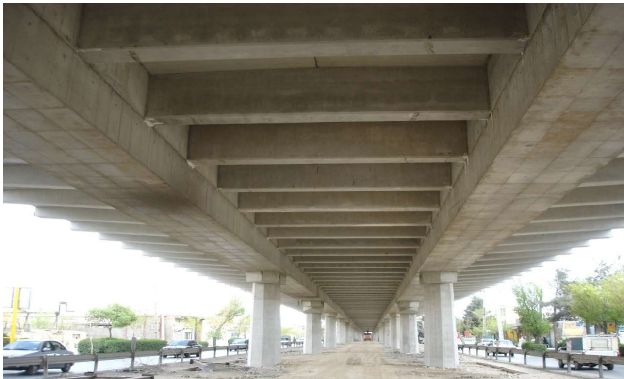
پل روگذر بزرگراه امام خمینی (ره) نمای زیر عرشه پل
