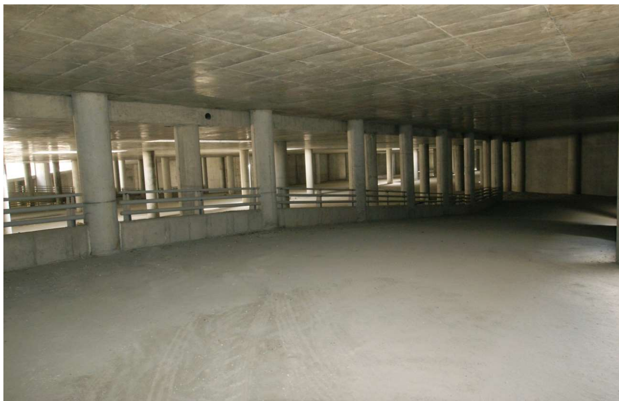
پروژه روگذر، زیرگذر و پارکینگ خیابان گلدسته رمپ های ورودی پارکینگ شماره ۲
