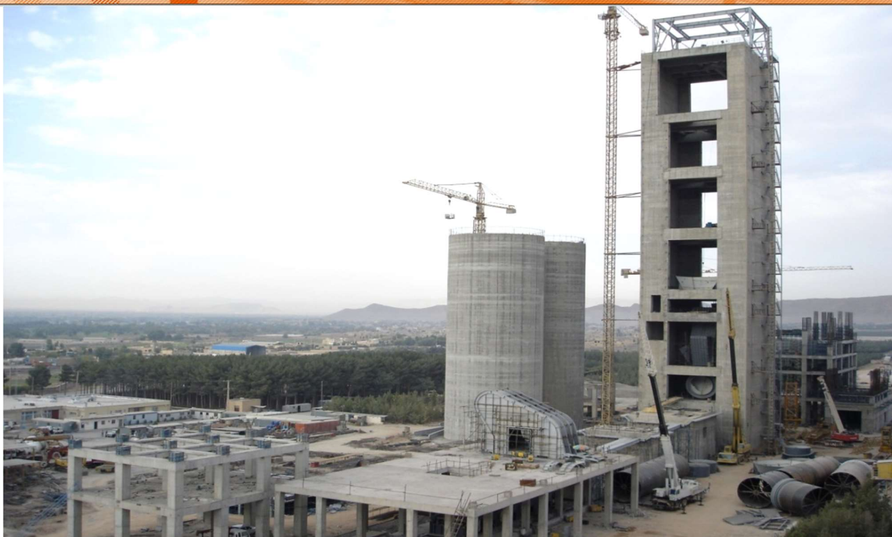
خط تولید سیمان ۳۳۰۰ تنی کارخانه سیمان سپاهان اجرای برج پری هیتز به ارتفاع ۹۲ متر و سیلوها به روش لغزنده
