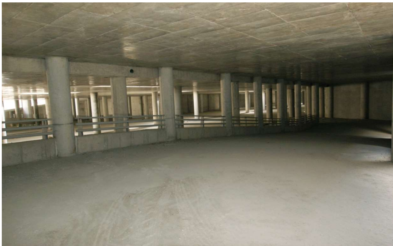
پروژه روگذر، زیرگذر و پارکینگ خیابان گلدسته رمپ های ورودی پارکینگ شماره ۱
