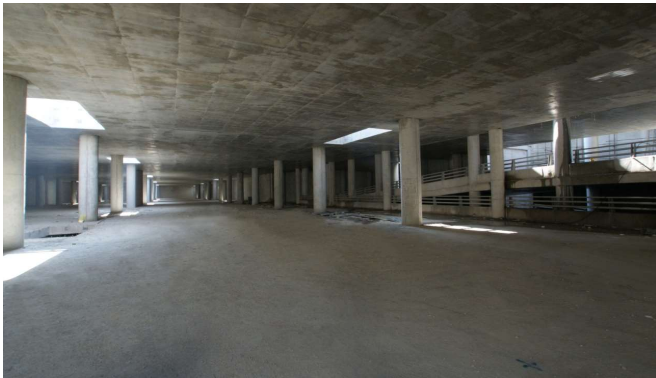
پروژه روگذر، زیرگذر و پارکینگ خیابان گلدسته طبقه ۱- زیرگذر
