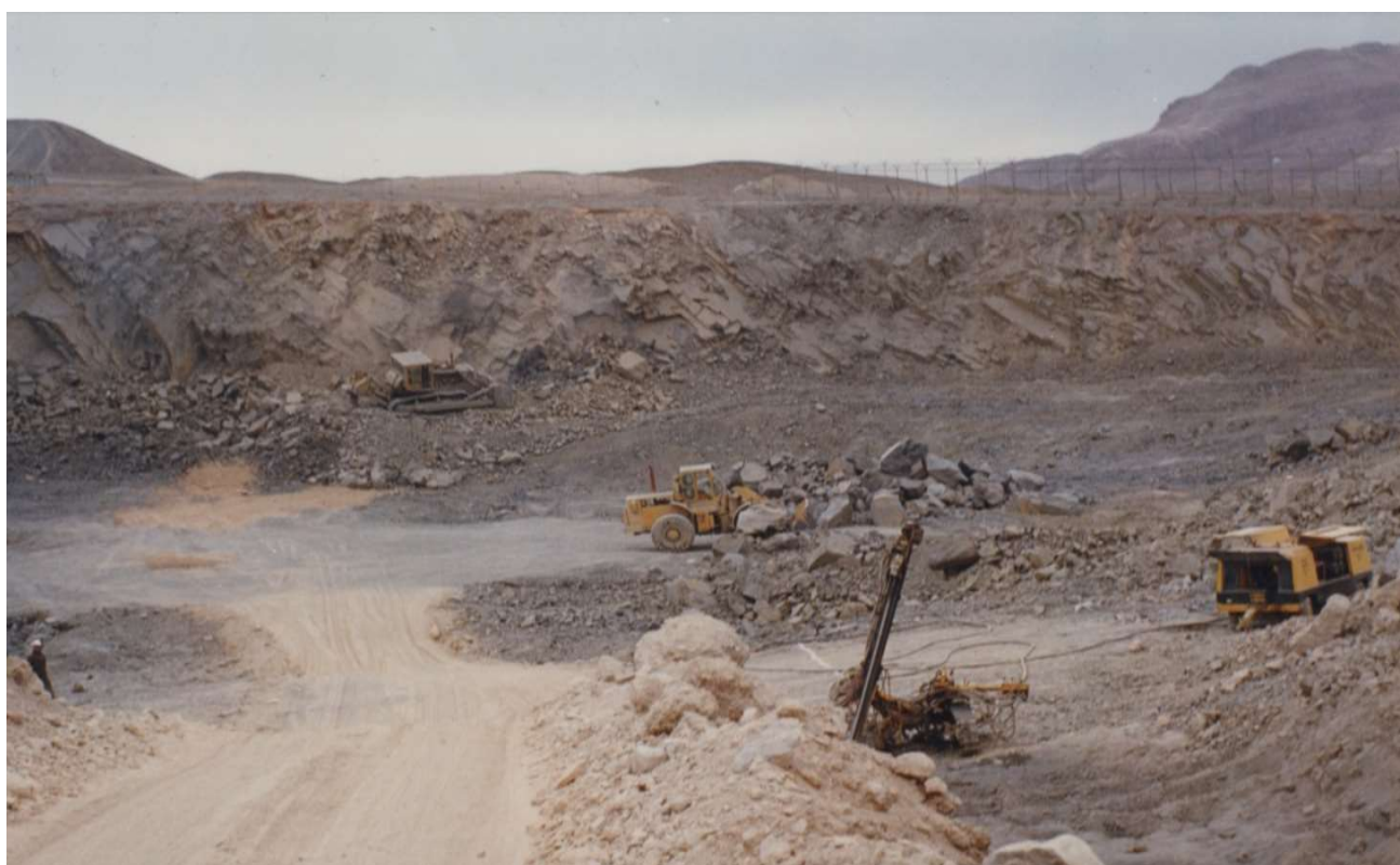
منبع آب ۷۰,۰۰۰ مترمکعبی شرق اصفهان خاکبرداری و سنگبری
