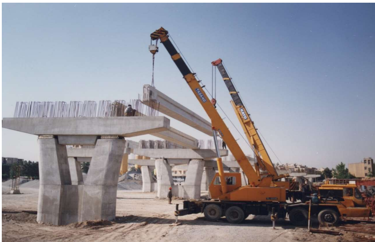
مجموعه پل‌های غدیر اصفهان سر ستونها و تیرهای نصب شده و در حال نصب
