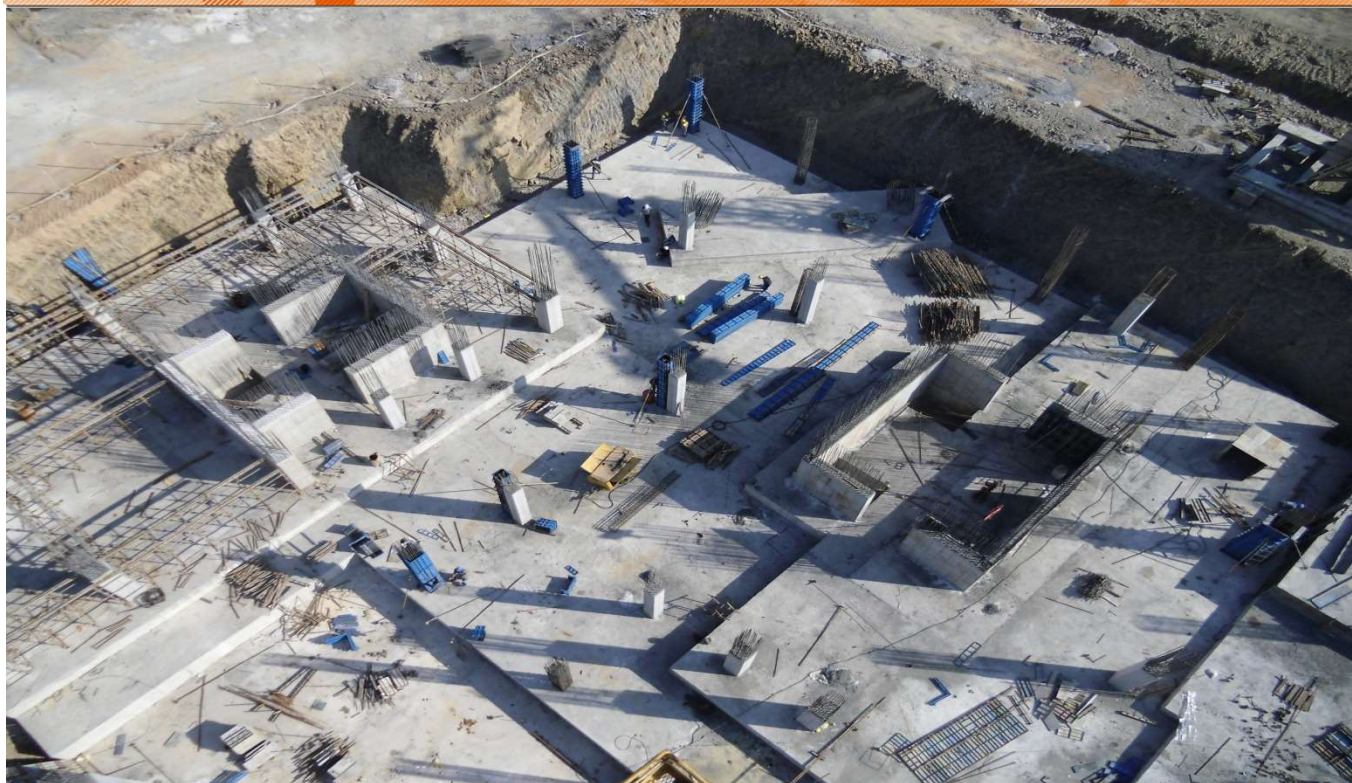
فونداسیون مجتمع مسکونی آبشار
