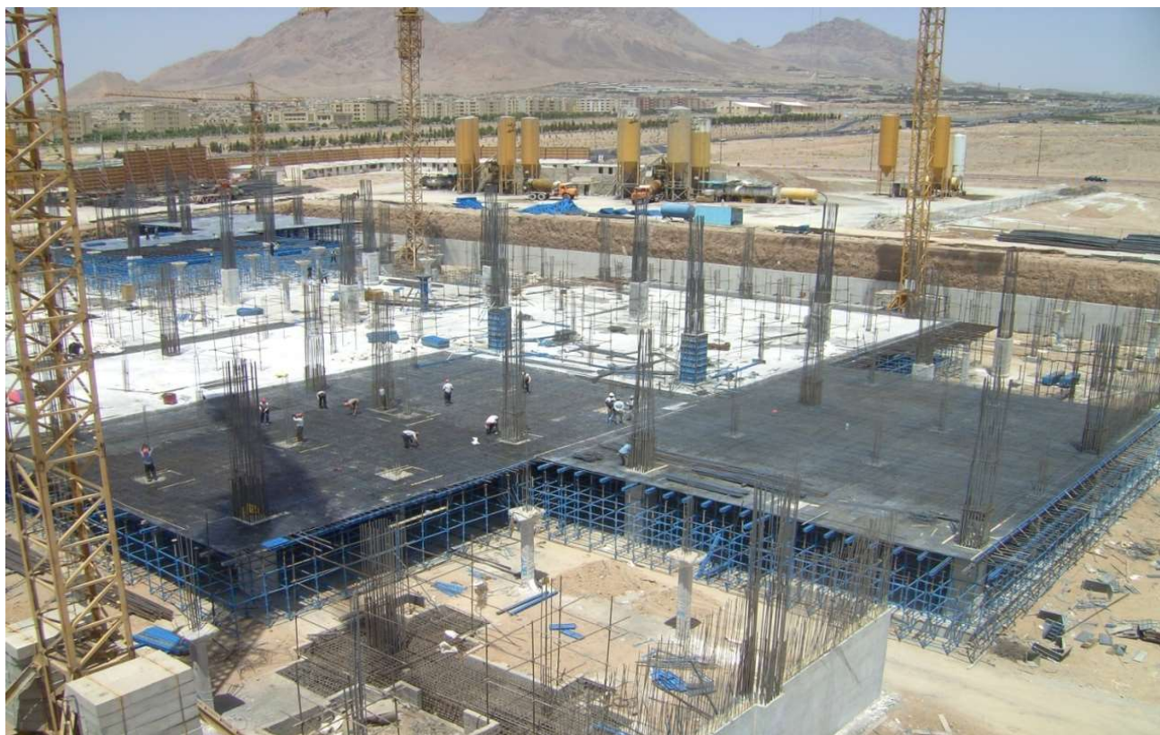
سیتی ستر اصفهان اجرای طبقه همکف
