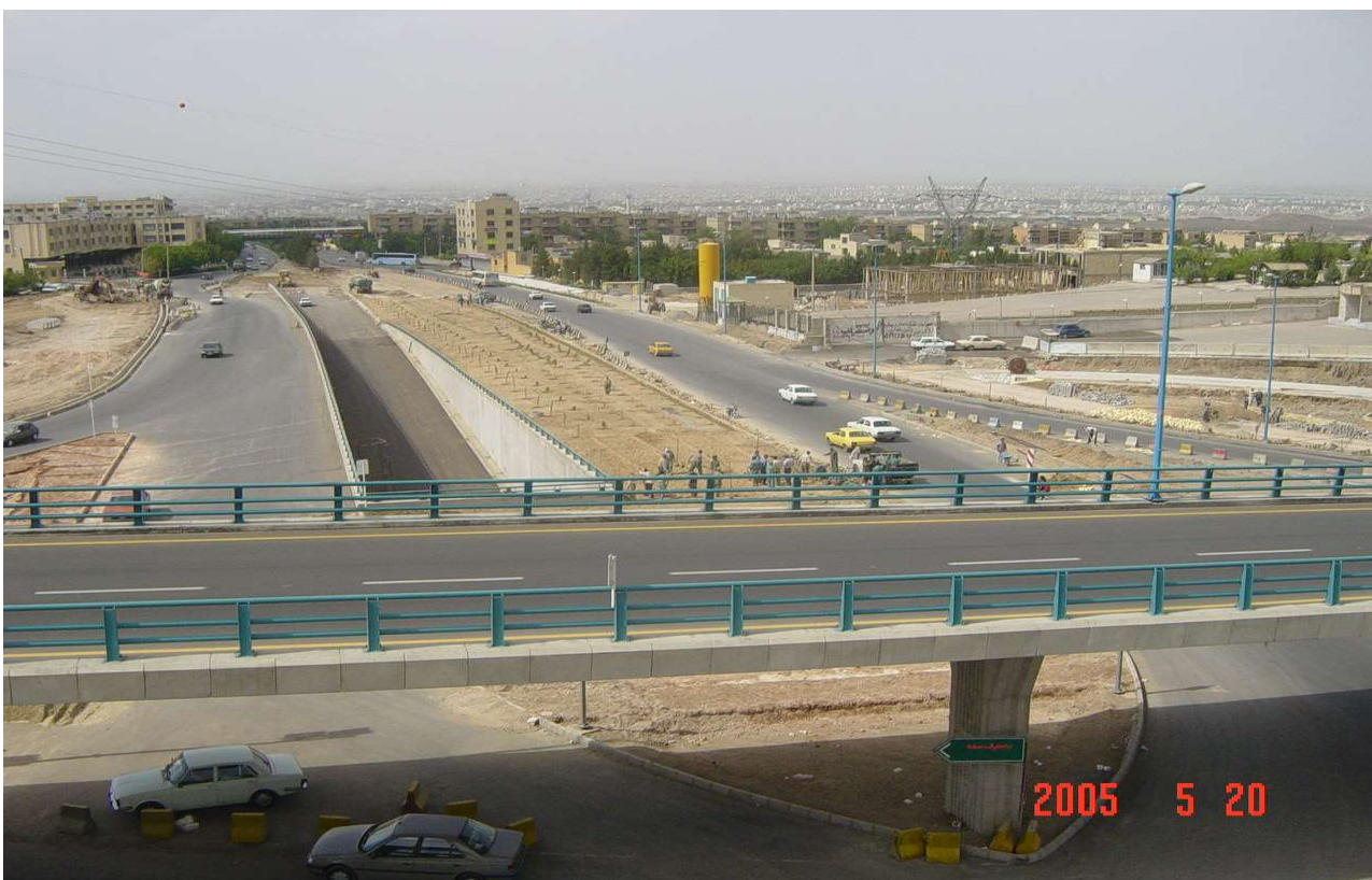
تقاطع غیر همسطح دفاع مقدس پل ۱۰۰ و ورودی زیرگذر
