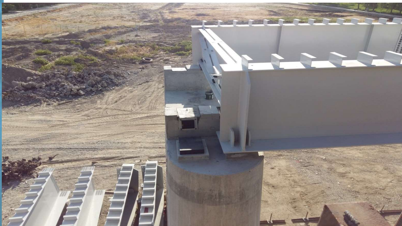
پل فلزی اصفهان تیرهای نصب شده و سر ستون پـــــــل
