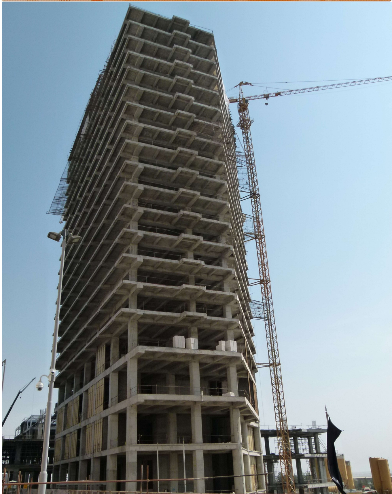
برج ۲۷ طبقه اداری سیتی سنتر در حال ساخت
