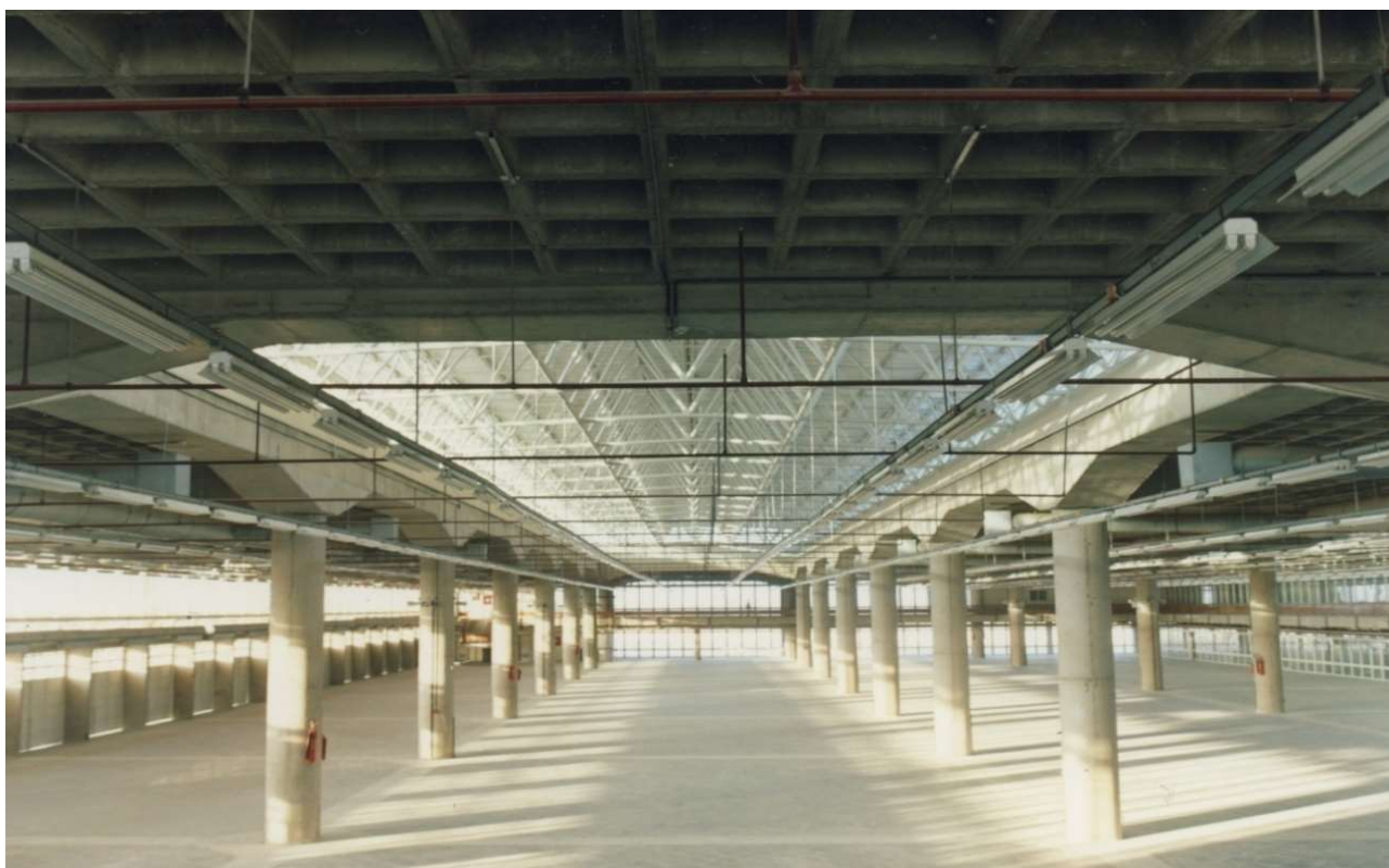
ساختمان پست مکانیزه اصفهان نمای داخلی و قاب فضائی
