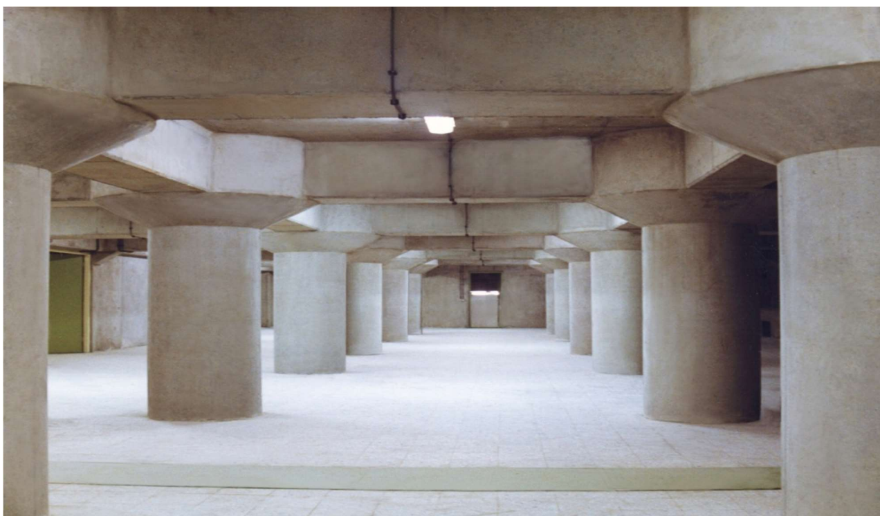
ساختمان پناهگاه و رختکنهای مجتمع فولاد مبارکه نمای داخلی
