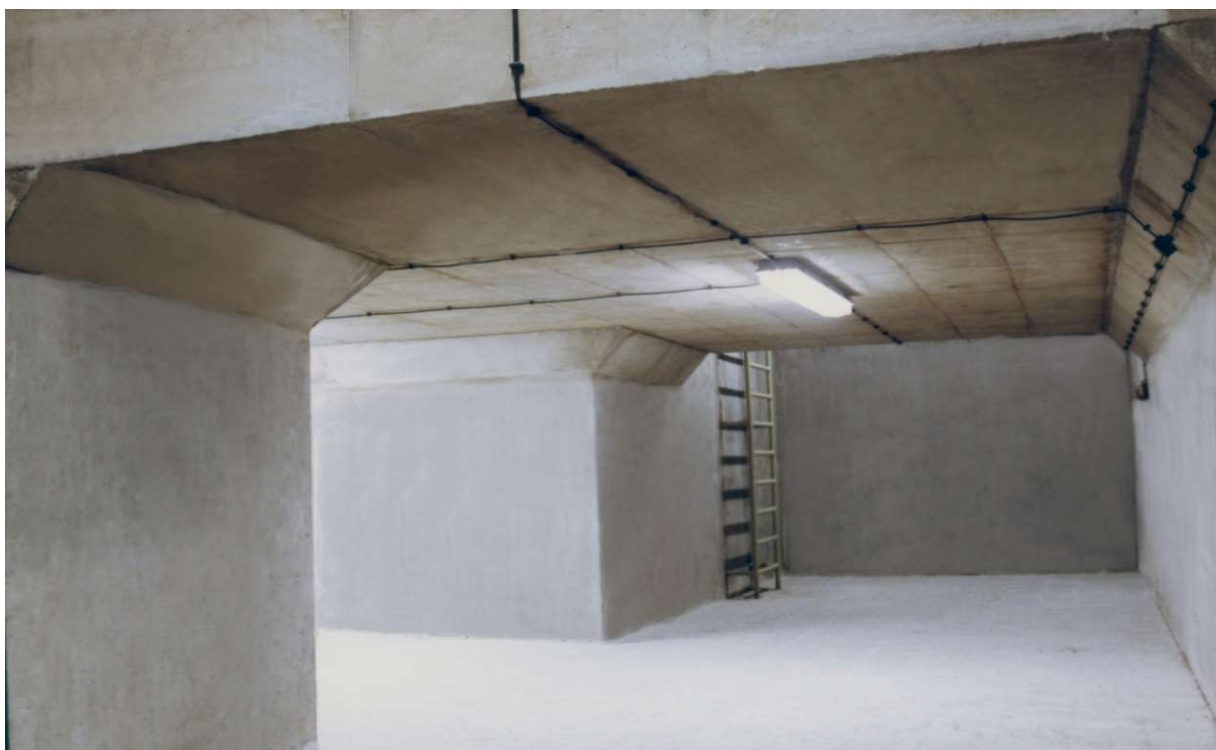
ساختمان پناهگاه و رختکنهای مجتمع فولاد مبارکه نمای داخلی
