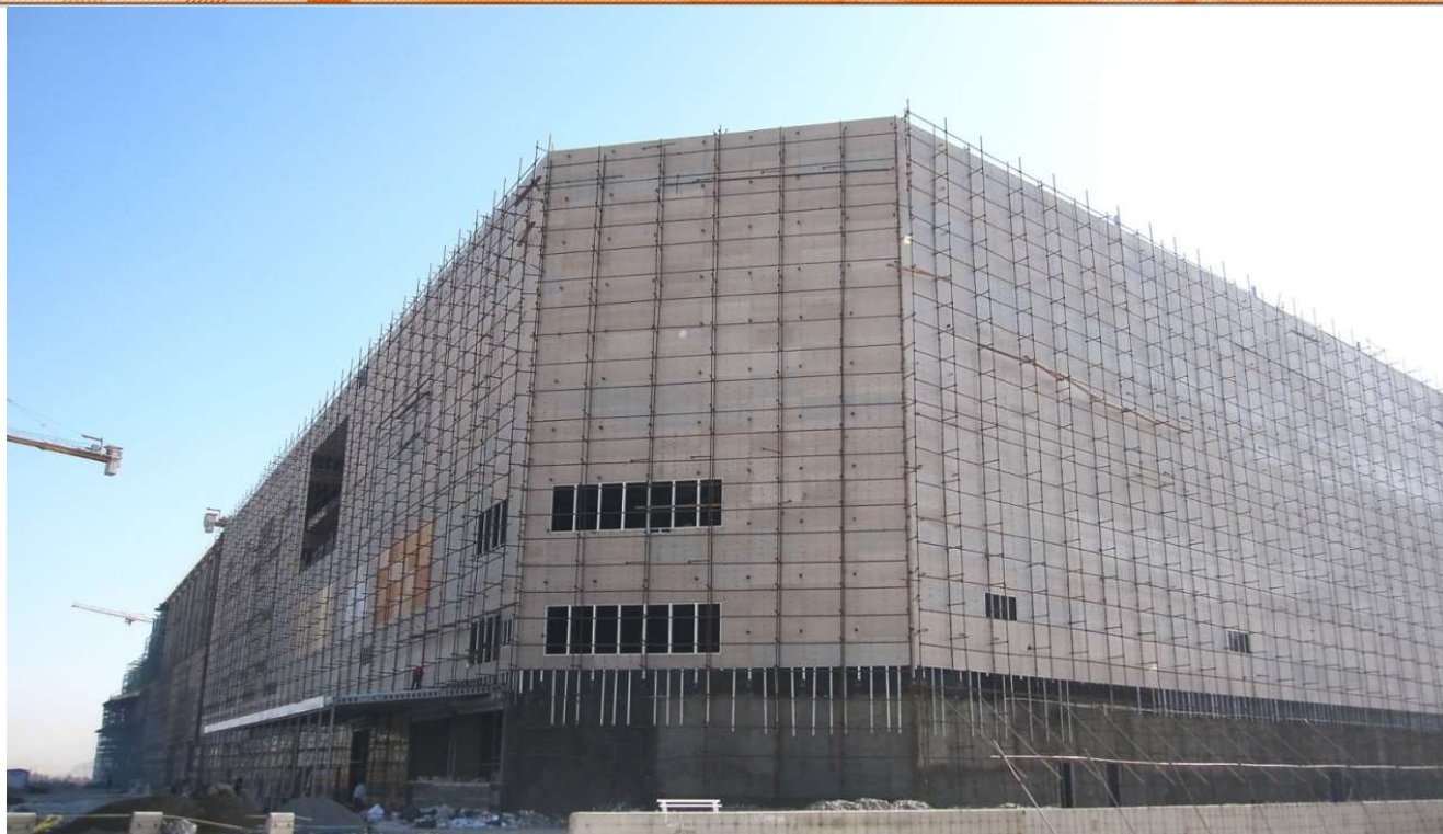
سیتی سنتر اصفهان سازه بتنی با دهانه های ۲۴ متری تا ارتفاع ۵۰ متر
