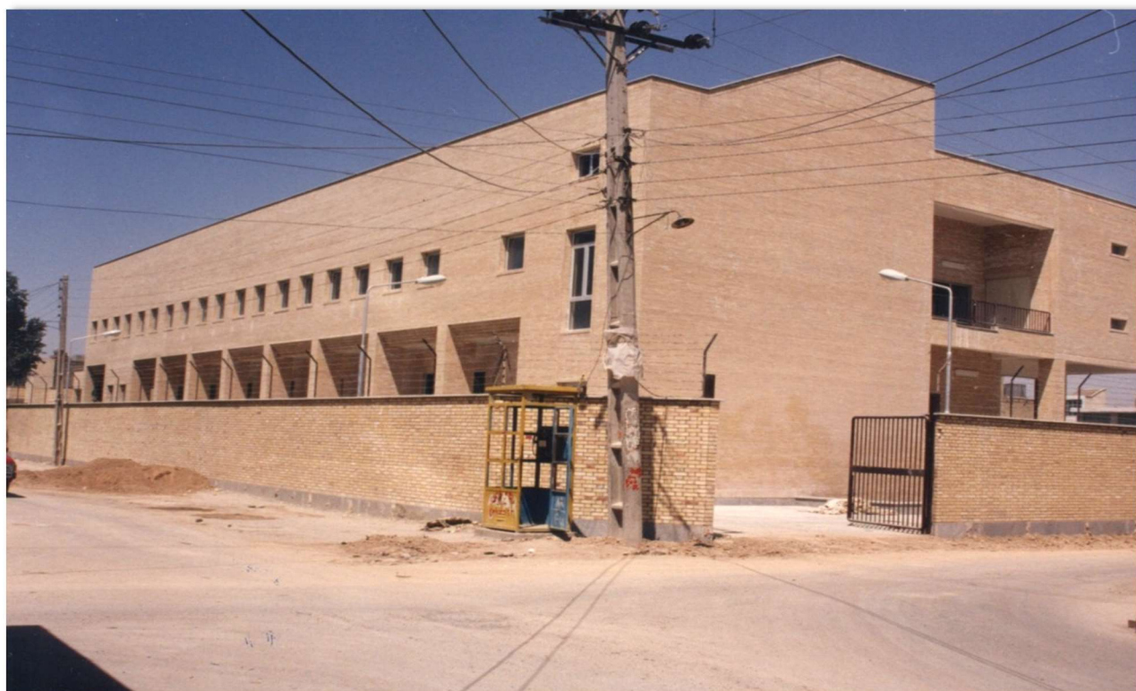
ساختمان مرکز مخابرات بزرگمهر اصفهان نمای بیرونی
