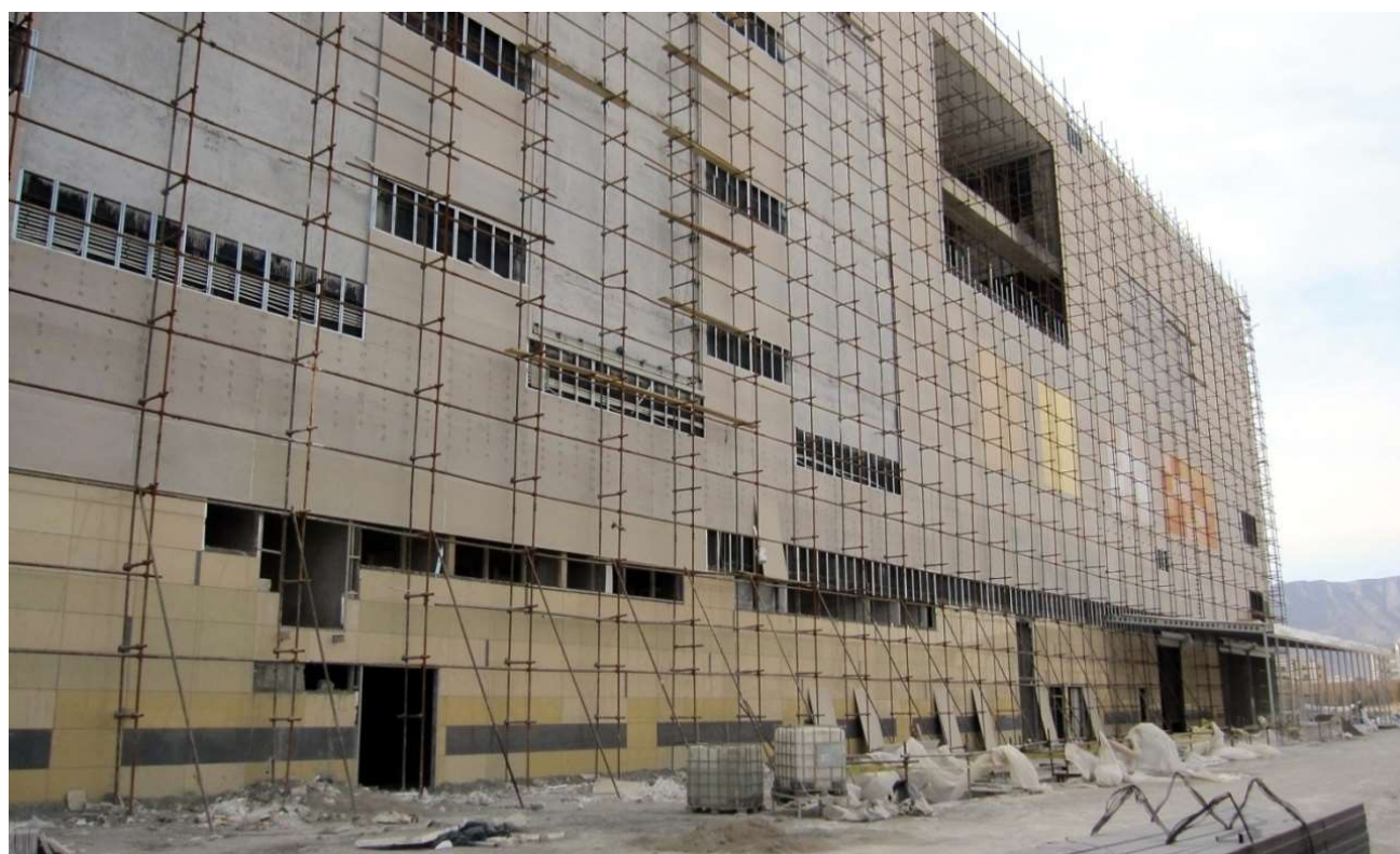
سیتی سنتر اصفهان سازه بتنی با دهانه های ۲۴ متری تا ارتفاع ۵۰ متر
