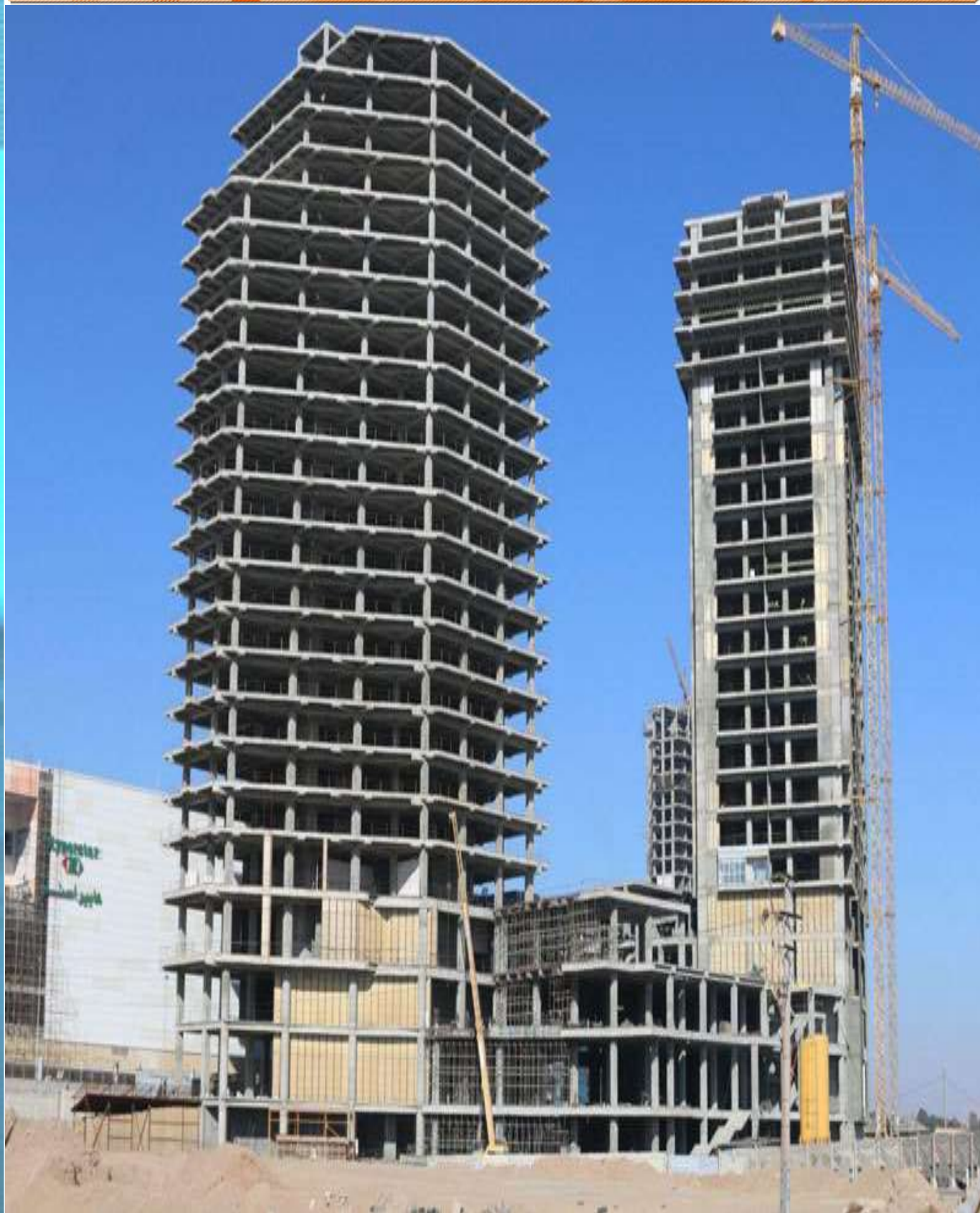
برجهای مسکونی IFC1 و اداری IFC5 و مجموعه تجاری IFC4 سیتی سنتر در حال ساخت
