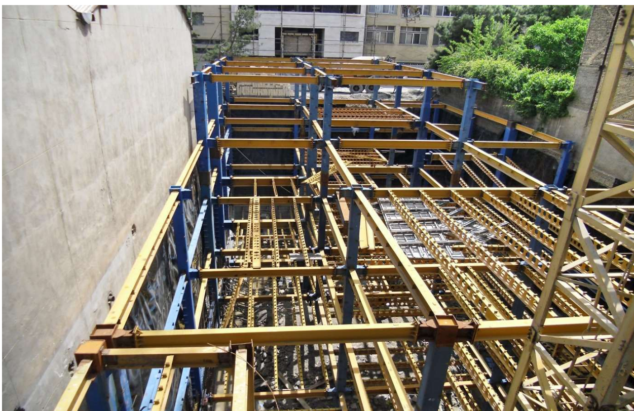
ساختمان مدیریت شعب بانک تجارت در حال انجام عملیات نیلینگ و خاکبرداری مخصوص به علت وضعیت بسیار خطرناک ساختمانهای قدیمی اطراف پروژه در در یکی از قسمتهای شلوغ شهر
