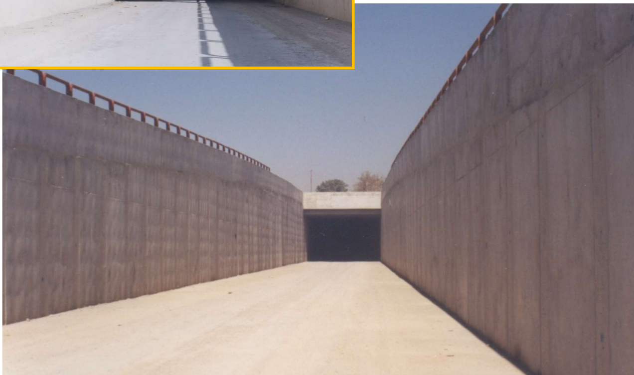
متروی شمالی اصفهان تونل U-WALL از قطعه شماره ۵
