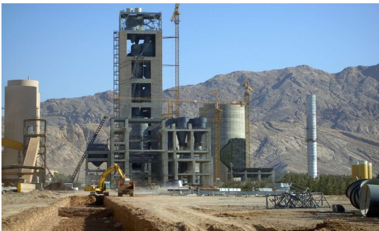
خط تولید سیمان ۳۳۰۰ تنی کارخانه سیمان سپاهان برج پری هیتز ، سیلوهای مواد و آسیاب مواد و...
