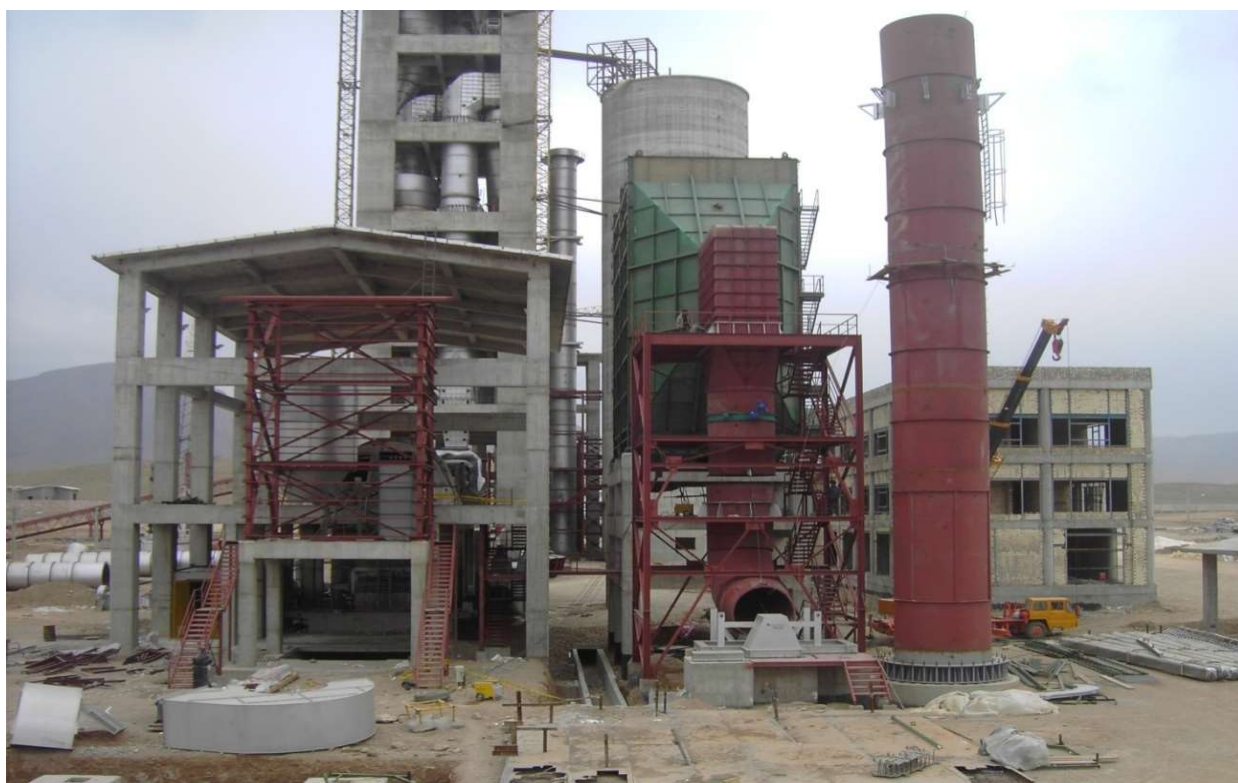
پروژه کارخانه سیمان ۲۲۰۰ تنی سیمان ساروج قسمتی از سایت شامل: سیلوا، برج پری هیتر، آسیاب مواد و...
