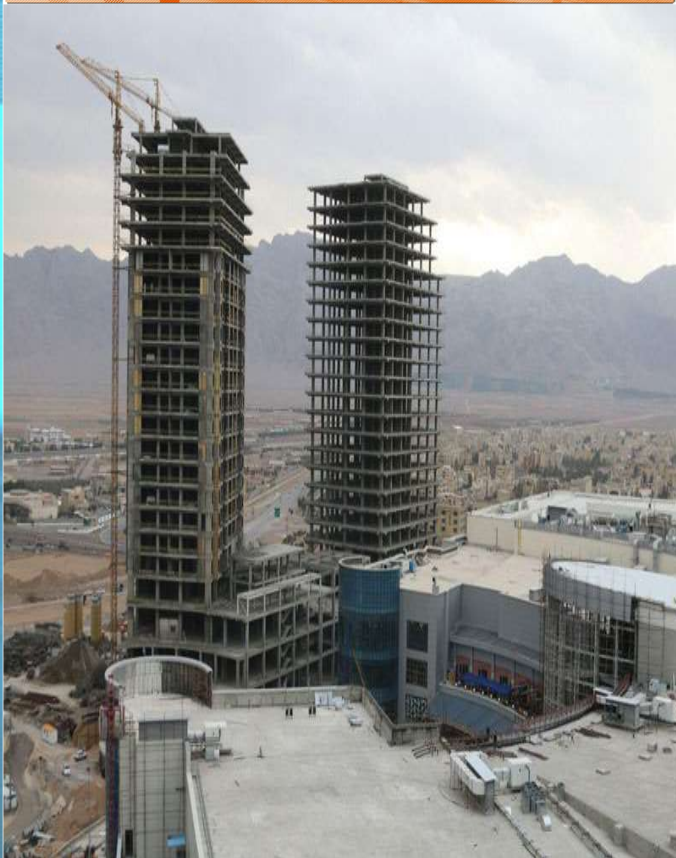
برجهای مسکونی و اداری و مراکز تجاری
