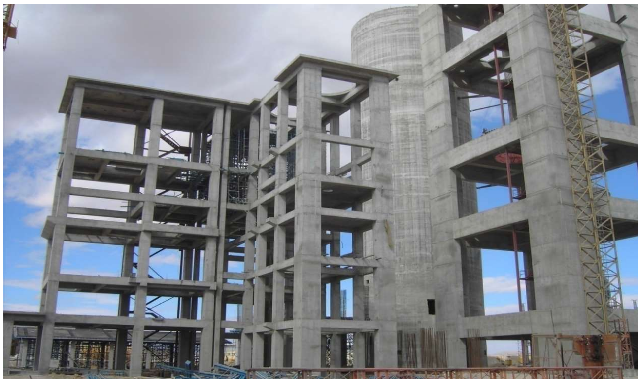
پروژه کارخانه سیمان ۲۲۰۰ تنی سیمان ساروج قسمتی از سایت شامل: سیلوها ، برج پری هیتز و...
