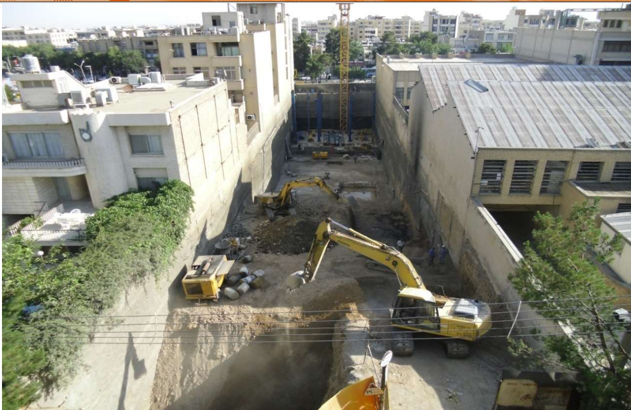
ساختمان مدیریت شعب بانک تجارت در حال انجام عملیات نیلینگ و خاکبرداری مخصوص به علت وضعیت بسیار خطرناک ساختمانهای قدیمی اطراف پروژه در در یکی از قسمتهای شلوغ شهر
