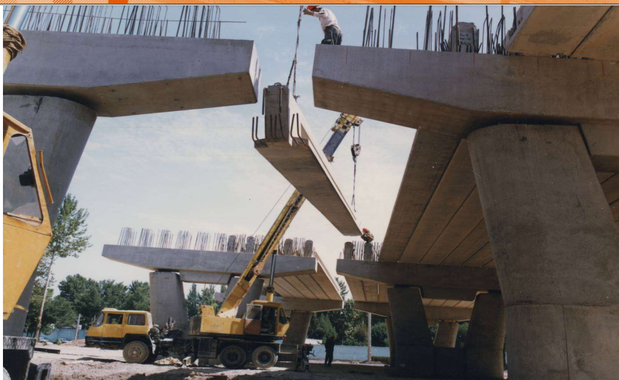
مجموعه پل‌های غدیر اصفهان سر ستونها و تیرهای نصب شده و در حال نصب
