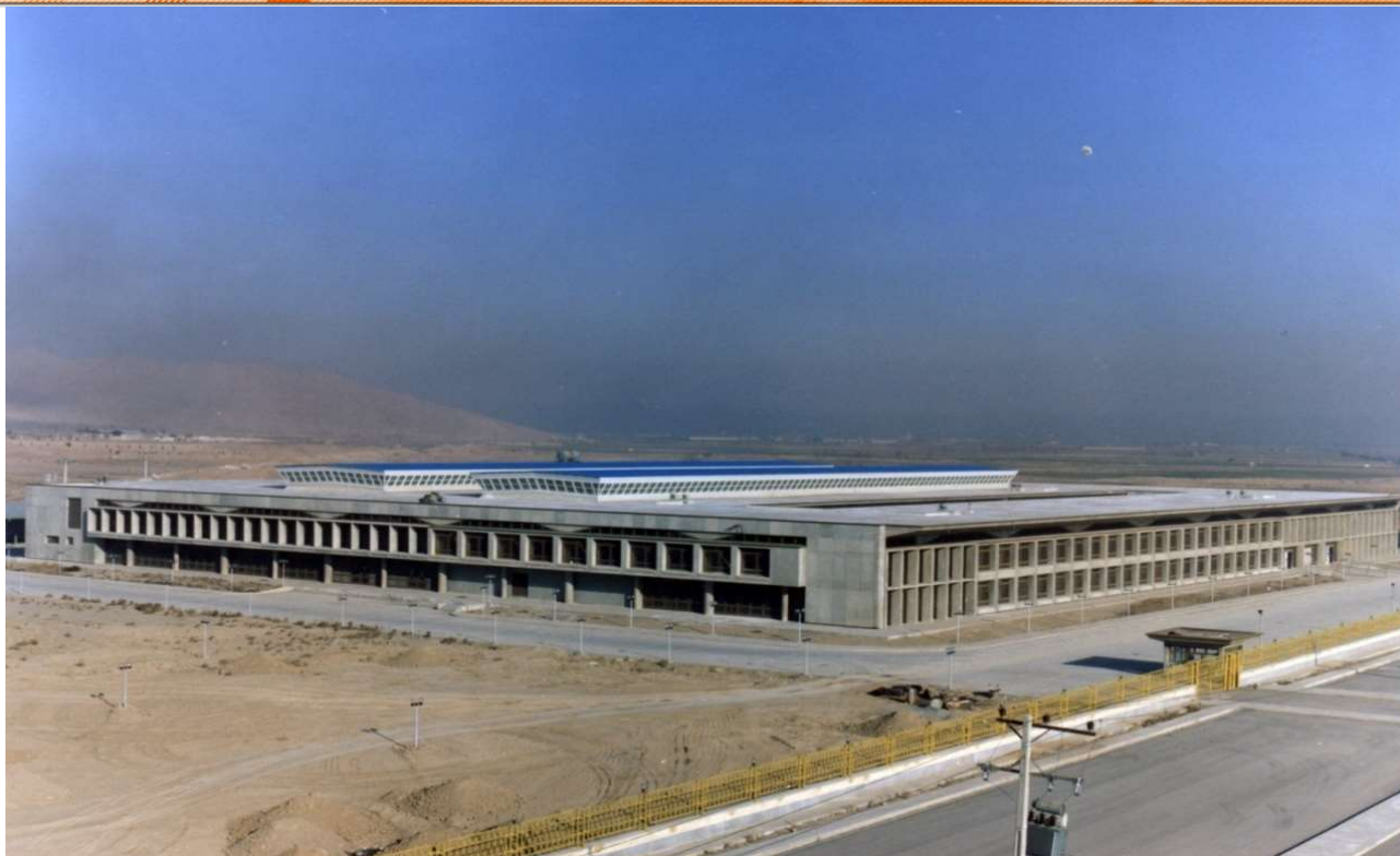
ساختمان پست مکانیزه اصفهان نمای بیرونی و قاب فضائی
