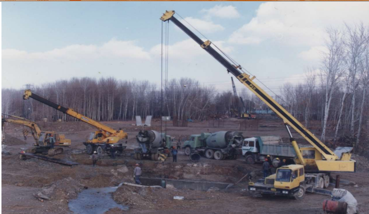
مجموعه پلهای غدیر اصفهان کشیدن آب از فونداسیون و ریختن بتن آن
