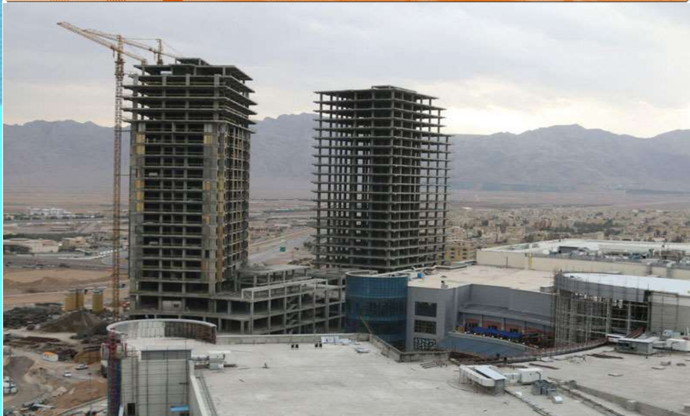
برجهای مسکونی IFC1 و اداری IFC5 و مجموعه رفاهی IFC3 سیتی سنتر در حال ساخت
