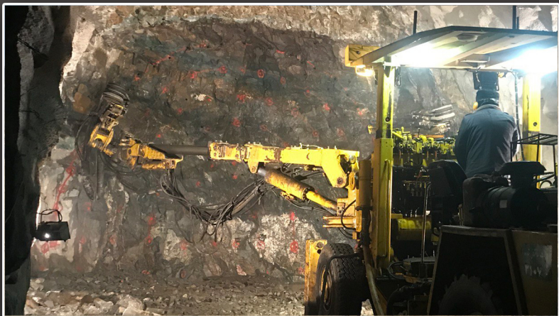
محور خرم آباد - پلدختر قطعه ۲
