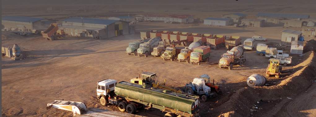
کمپ کارگاه راه آهن تهران - ساوه - همدان قطعه ۲
