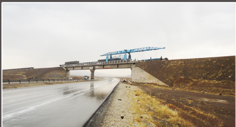
راه آهن تهران - ساوه - همدان قطعه ۲ پل تقاطع آزادراه ساوه - همدان با راه آهن
