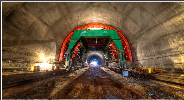
محور ترانزیتی درگز - لطف آباد ( تونل گلخندان )
