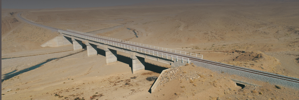
پل رودخانه ای چمرود - راه آهن تهران - ساوه - همدان قطعه ۲
