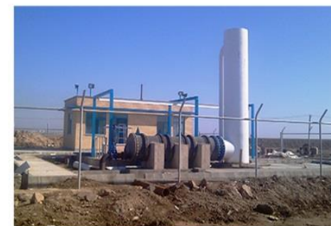
پروژه احداث ایستگاههای پمپاژ آبیاری و زهکشی خرمشهر
