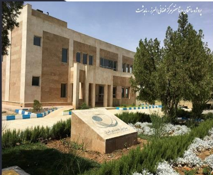
پروژه ساختمان دیتا سنتر و رصد خانه مرکز فضایی ماهدشت - استان البرز
