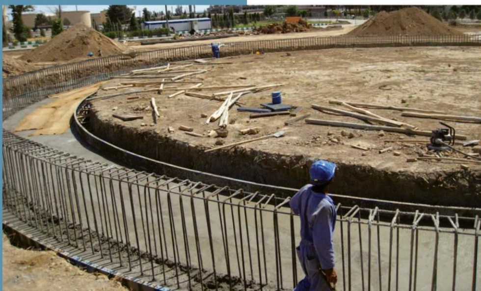
▶ اجرای آرماتور و قالب بندی فونداسیون مخازن
