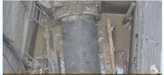
عملیات شبکه اصلی جمع آوری فاضلاب (میکروتونلینگ) از بونگ به تصفیه خانه فاضلاب شوک غرب
