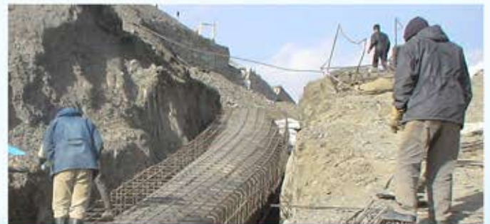
عملیات خط انتقال، راه دسترسی و حفاظت کالبدی طرح آبرسانی سمنان از چشمه روزبه
