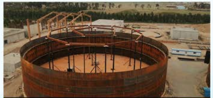
طراحی، خرید، ساخت، نصب و راه اندازی تصفیه آب دریافتن از تصفیه خانه جنوب تهران و انتقال آن در محوطه پالایشگاه
