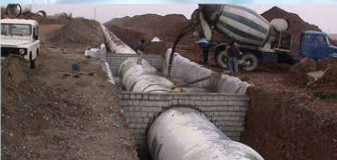
تصهیه خانه آب مشروب قم
