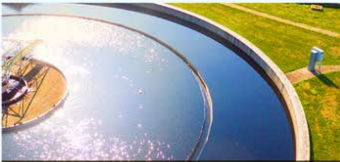
تجهه جایگزینی، نصب و راه اندازی تجهیزات مخزن ایستگاه پمپاژ و تصفیه خانه جدید نهند
