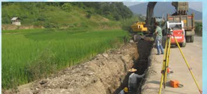
احداث و بهره برداری خط انتقال و تصفیه خانه آب ساری
