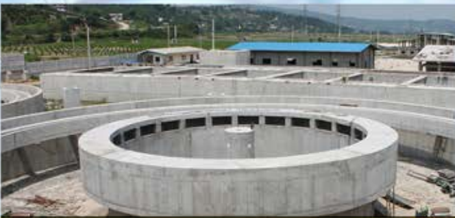
احداث و بهره برداری خط انتقال و تصفیه خانه آب ساری
