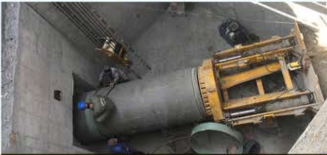
اجرای عملیات لوله رانی به روش میکروتونلینگ در محدوده جنوب و مرکزی تهران
