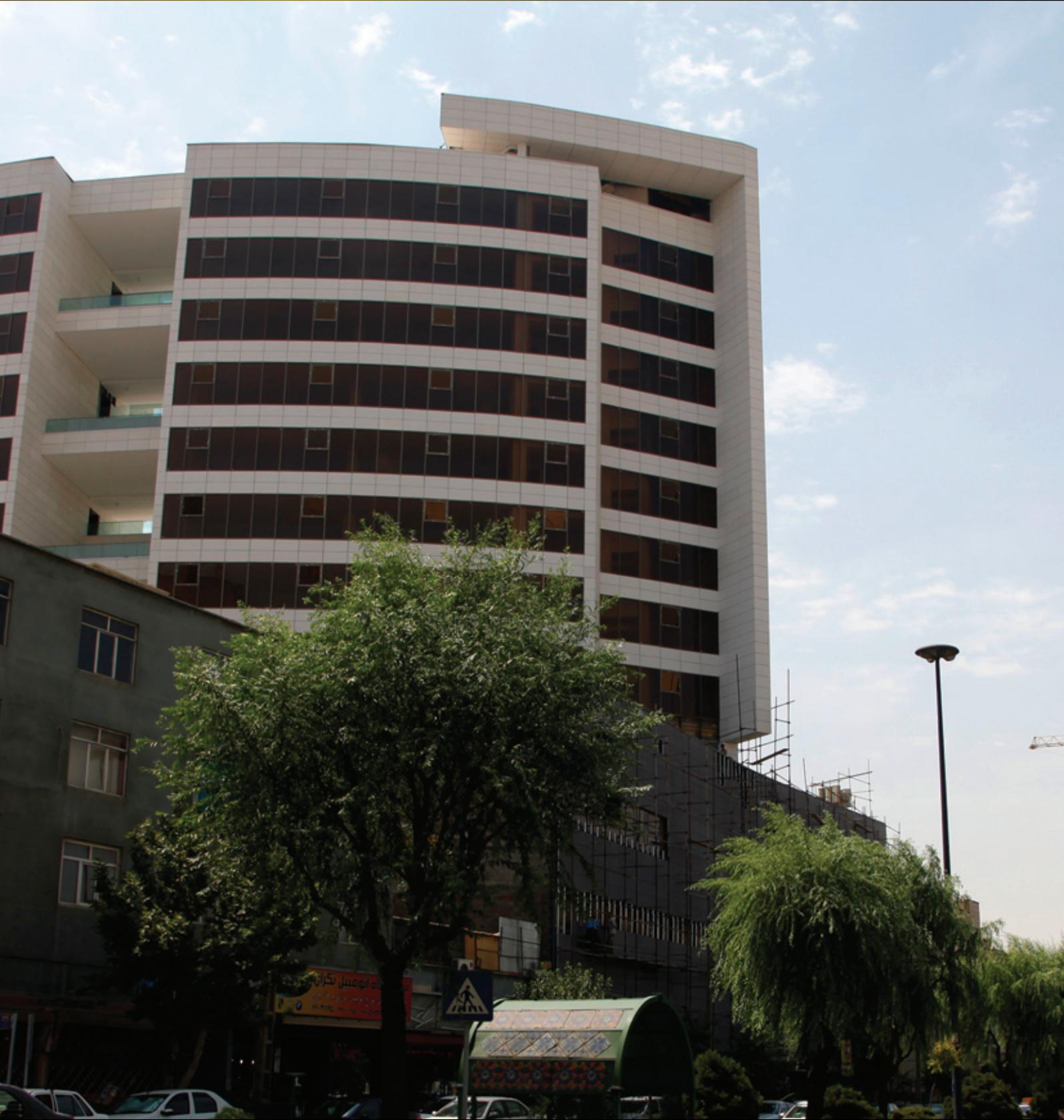
اسکلت ساختمان بالغ بر ۶۲۰۰ تن سازه پیچ و مهره‌ای است و در پوشش نمای ساختمان برای اولین بار در ایران از نمای Fiber Cement Board رنگی بهره گرفته شده و سیستم‌های PMS و BMS کل مجموعه را کنترل می‌کند و ساختمان از سیستم سرمایش و گرمایش و کنترل حریق کامل برخوردار می‌باشد.
