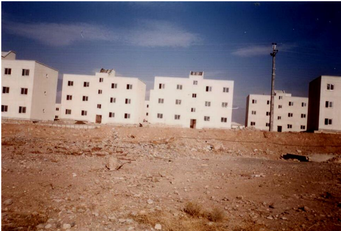
خانه سازی زلزله زدگان منجیل
