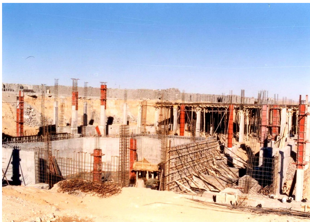
اجرای اسکلت بتنی
