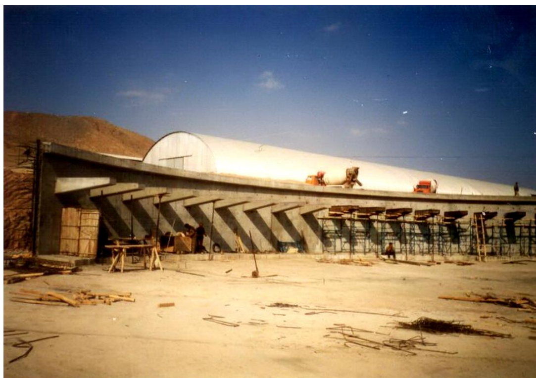
اجرای دیوار پوترهای پیش ساخته
