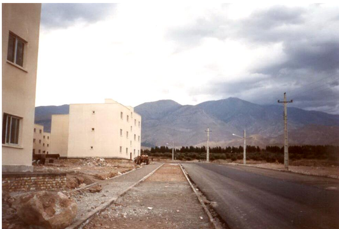
خانه سازی زلزله زدگان منجیل
